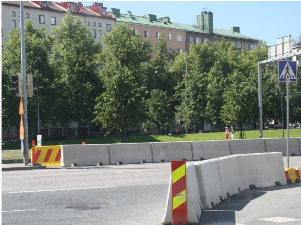
Kuva 9 Esimerkki tietyömaan suojarakenteesta: betonielementti. (Rudus 2019)
