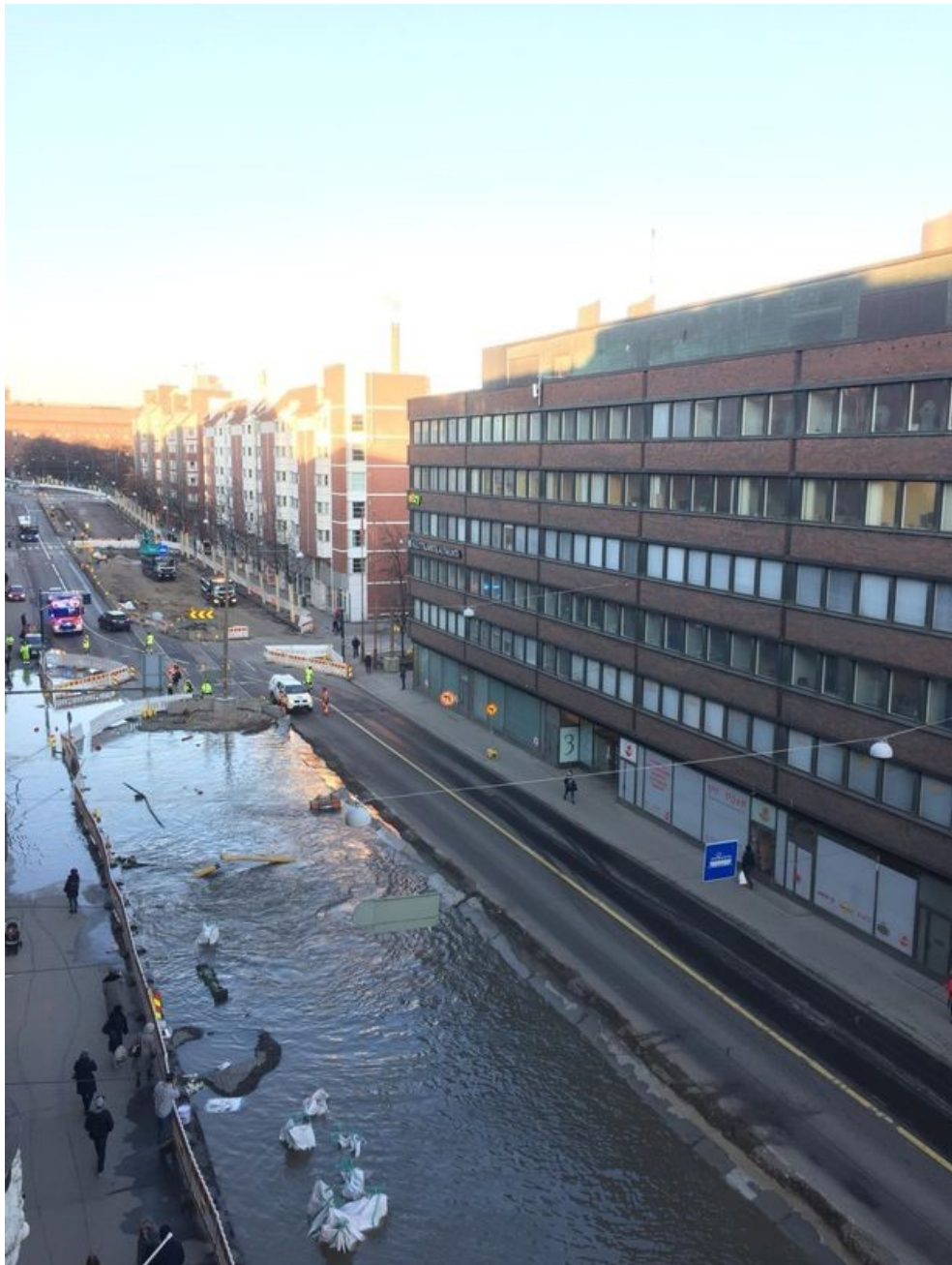
Kuva 18 Vesivahinko Hämeentiellä 2.4.2019 Hakaniemen kohdalla. (Ilta-lehti 2019)
