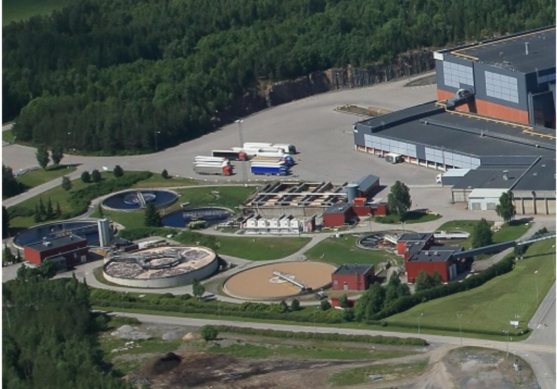
Kuva 3. Jätevedenpuhdistamo lähikuvassa (Sappi 2018).
