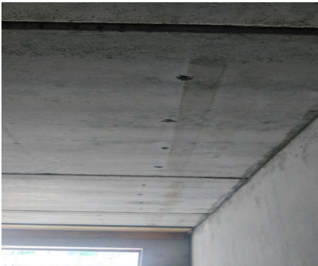
KUVA 4. Tehdasvalmisteiset vedenpoistoreiät avarrettuna poralla (min.16 mm).
