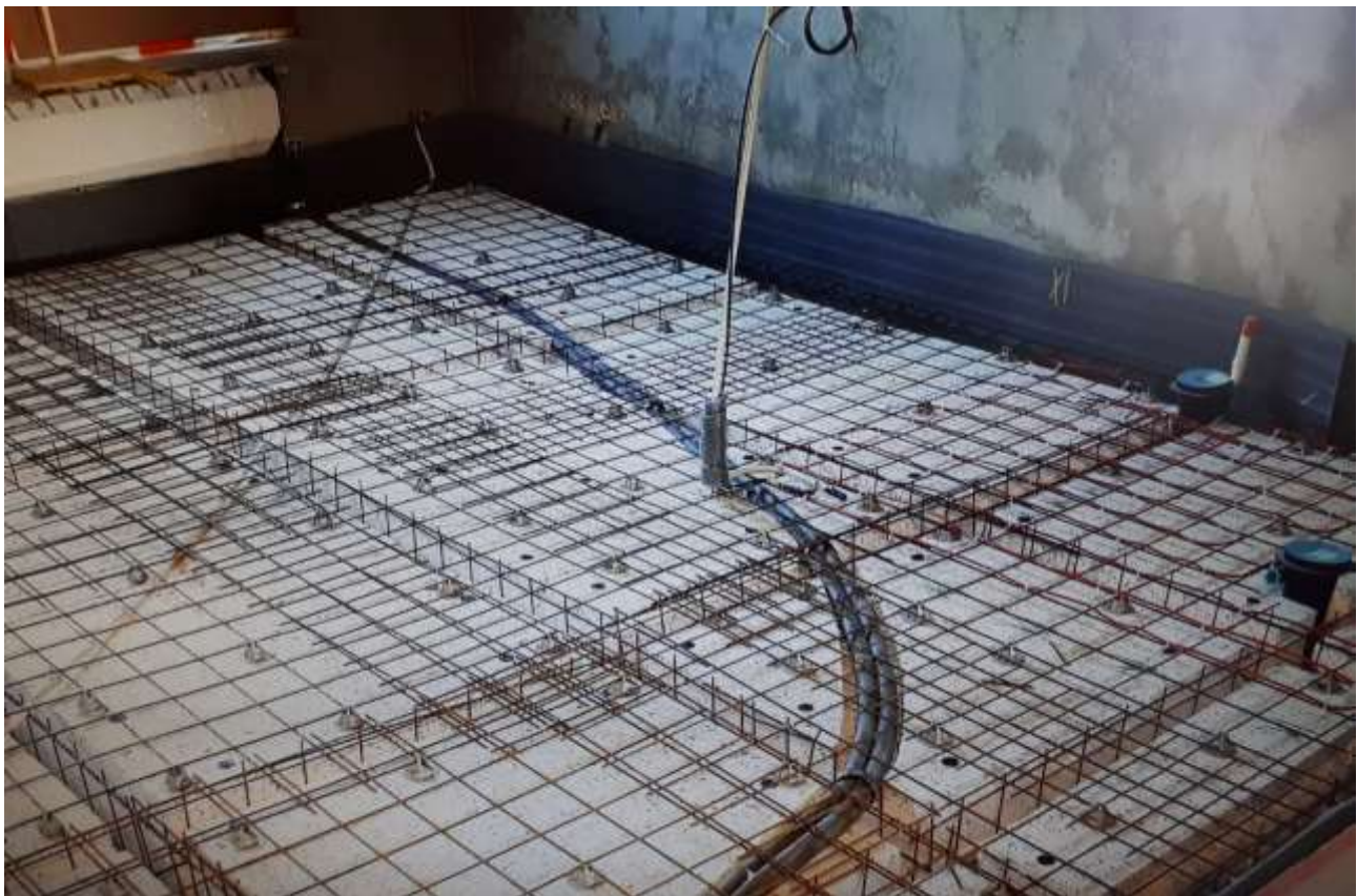
KUVA 3. Putkistot ja viemäröinnit kuvattuna
