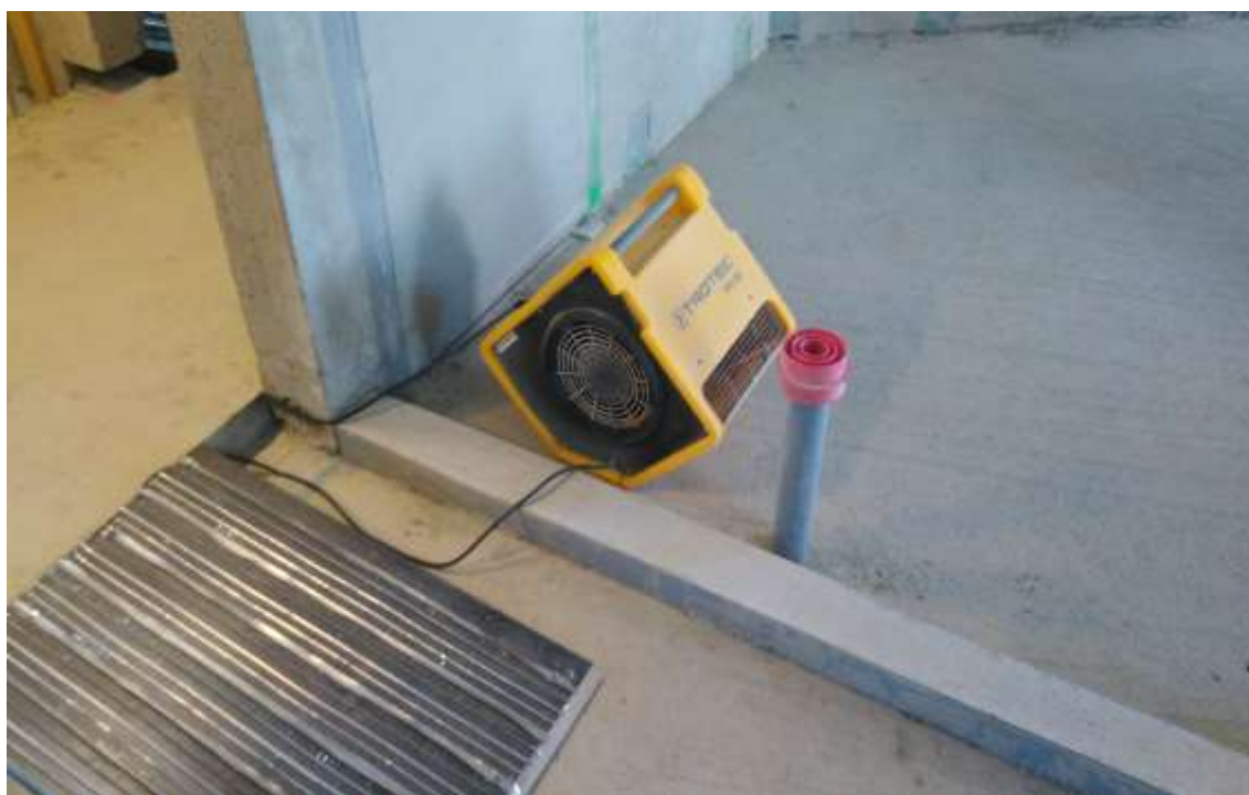
KUVA 4. Puhallin työmaalla (Hulpio 2019)
