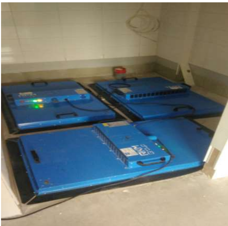
KUVA 2. Kylpyhuoneen kohdekuivaus työmaalla (Hulpio 2019)
