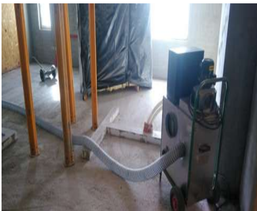
KUVA 3. Adsorptiokone työmaalla (Hulpio 2019)
