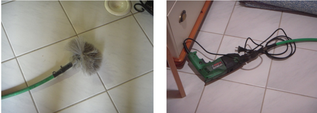
KUVA 2. Kanavapuhdistuksessa käytetty harja ja porakone
