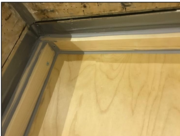
Kuva 8. Levy asennettuna ja tiivistettynä
