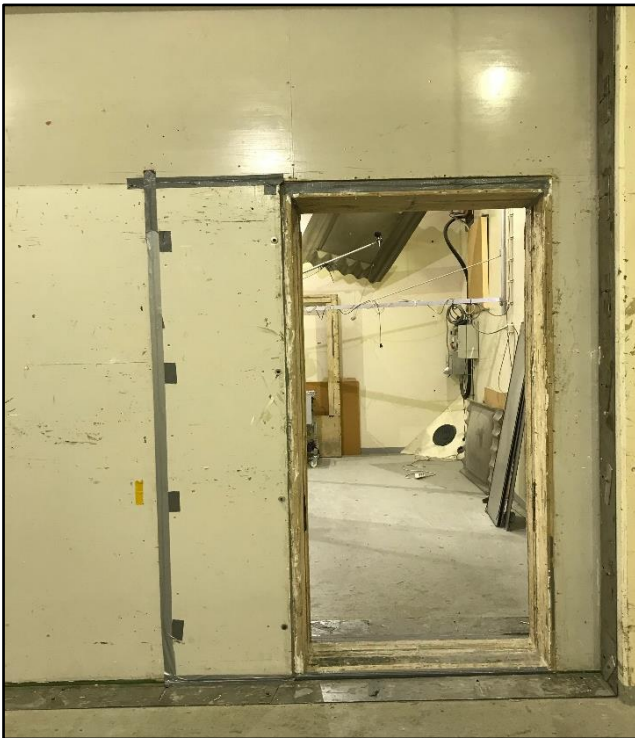
Kuva 7. Ovikoon aukko, johon levyt asennettiin
