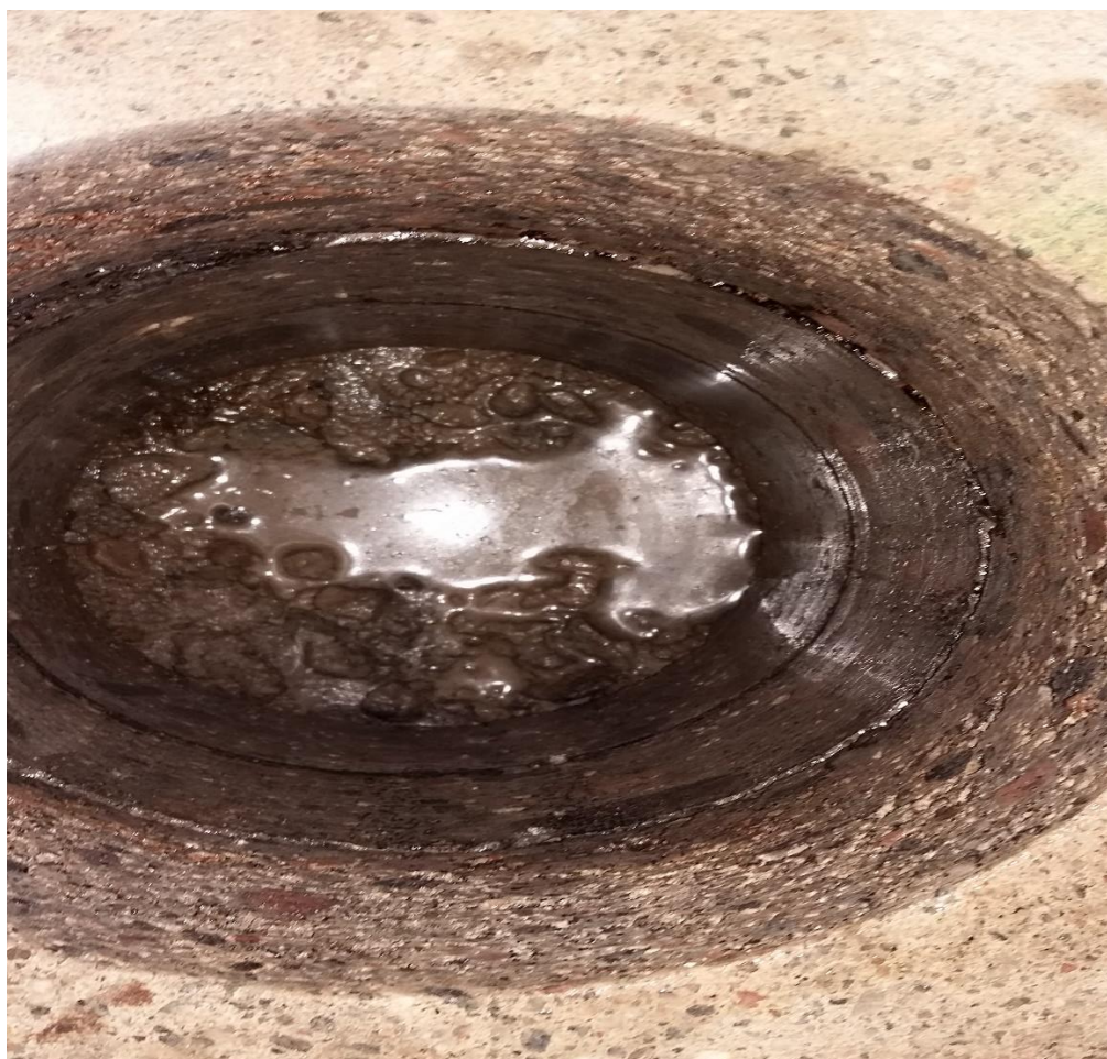
Kuva 12 Kellarin pilaantunut maa-aines
