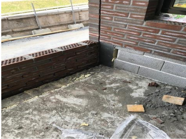
Kuva 14. Keskeneräinen käännetty vesikatto
