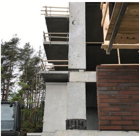
Kuva 15. Pilari asennettu vinoon
