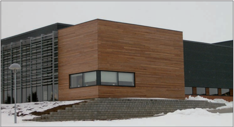
Kuva 3. Tanskan Ry:ssä sijaitseva Pressalit plant & offices -julkisivu, jonka puulaji on Western Red Cedar. Julkisivu on painekyllästetty luokkaan EN 13501-1, Euroclass B, s2, d0 Wolmanit Firestop:lla ja pintakäsitelty Innoshield DRF:llä.
