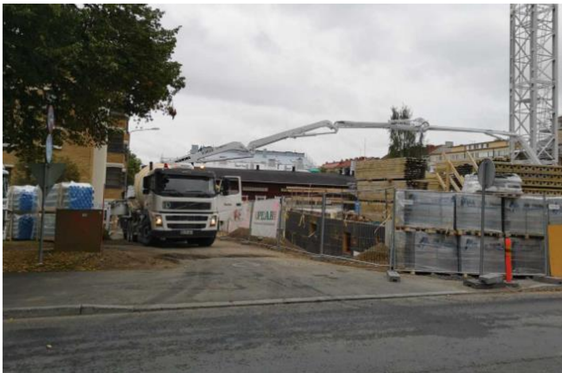
Kuva 4. Betonipumppuauto keskellä rännikatua. Muu liikenne on täysin poikki (Juvonen 2019).
