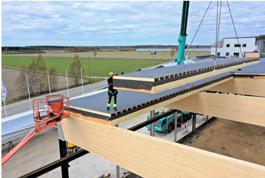
Kuva 21. Kattoelementin asennus liikerakennukseen. (Termater 2019b)
