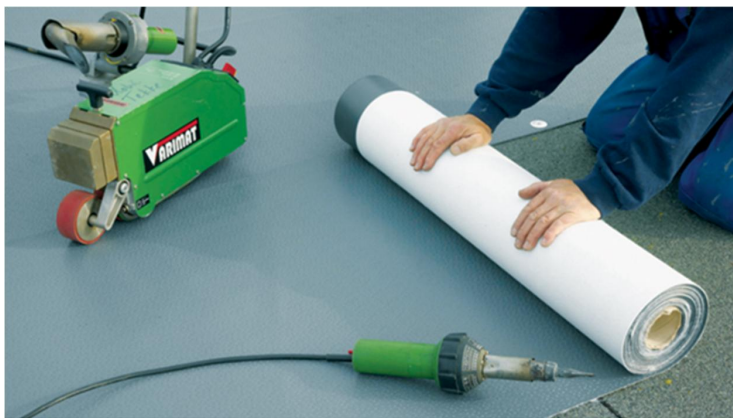
Kuva 14. Protanin asennus. Alustana poiketen bitumikermi (Protan 2019b)
