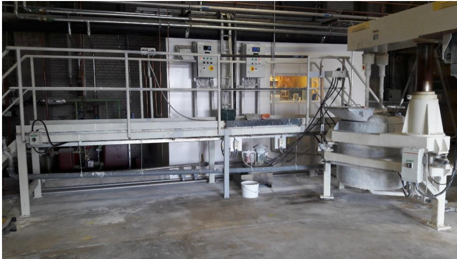
Kuva 6. Liettomikseriaseman käyttötaso purkutöiden jälkeen.
