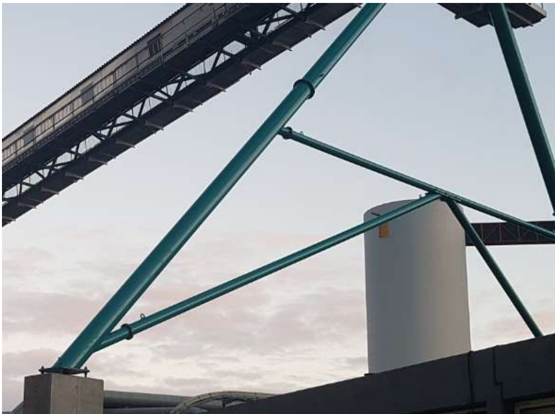
Kuva 12. Lohkotettu jalkarakenne. Jalan alapää vielä ilman jälkivalua.
