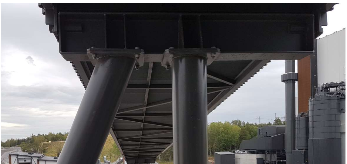
Kuva 11. Jalan yläpään asennus kuljetinsiltaan sekä jalan yläpalkki ja haarukka.
