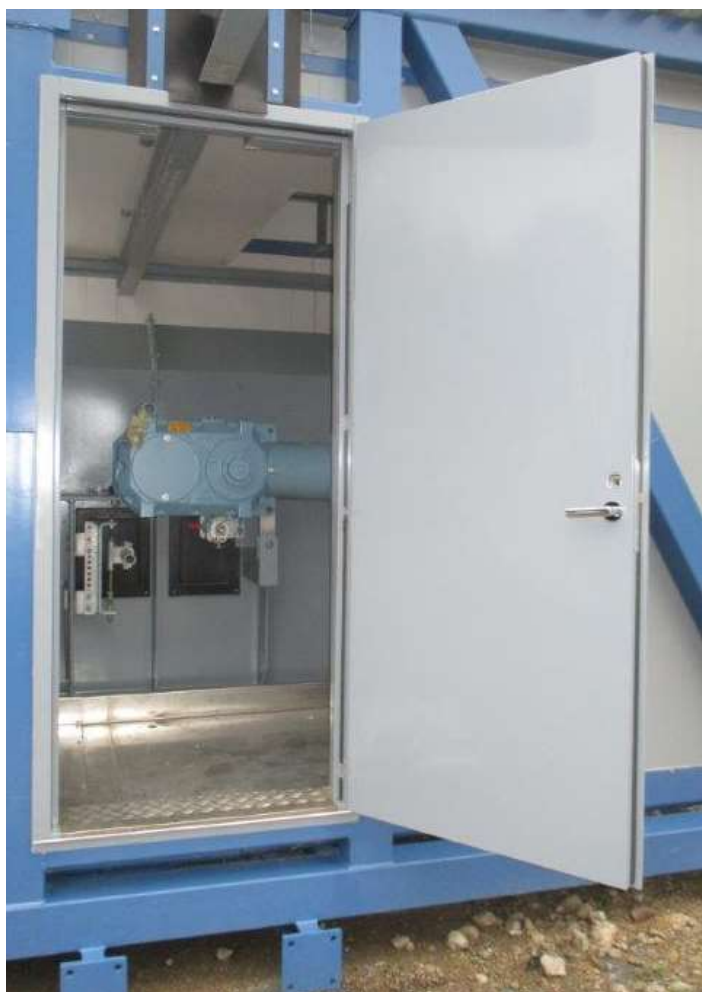
Kuva 17. Palo-ovi kuljetinsillan vetopäässä.
