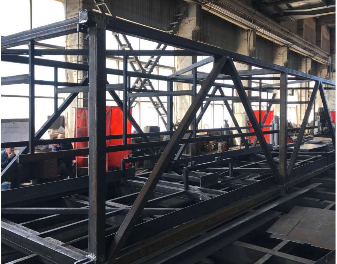
Kuva 2. Siltaristikko hitsausvaiheessa konepajalla.
