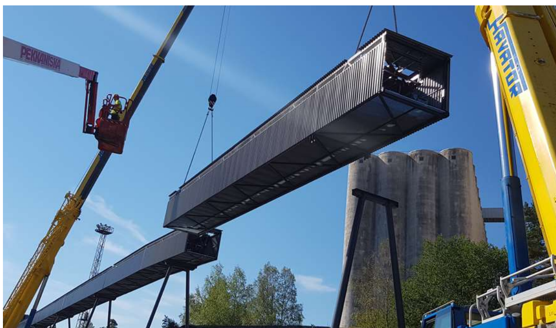
Kuva 15. Nostolohkojen nostoa paikalleen.
