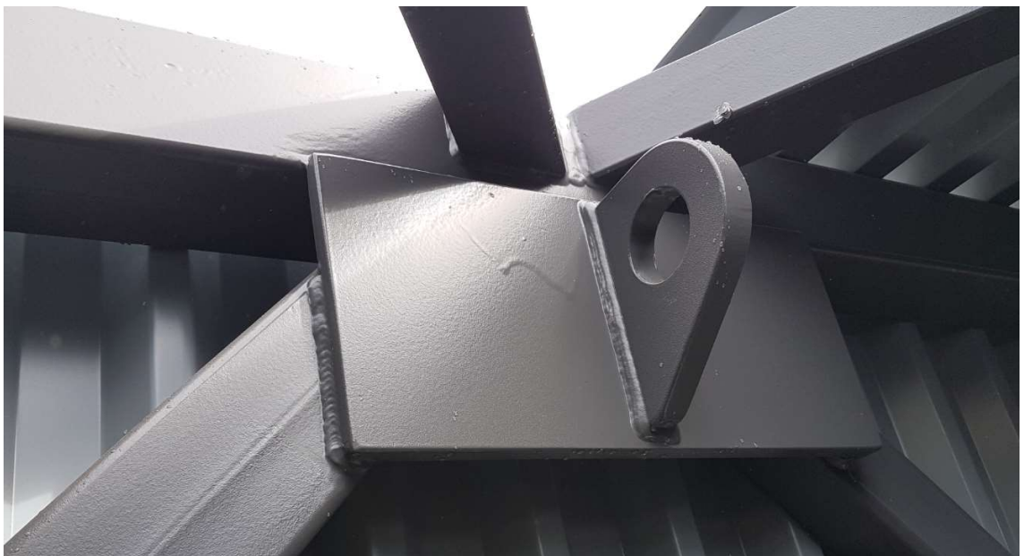
Kuva 9. Kuljetinsillan nostokorva.
