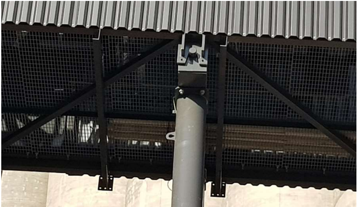
Kuva 10. Jalan yläpään asennus kuljetinsiltaan ja jalan yläpalkki sekä haarukka.
