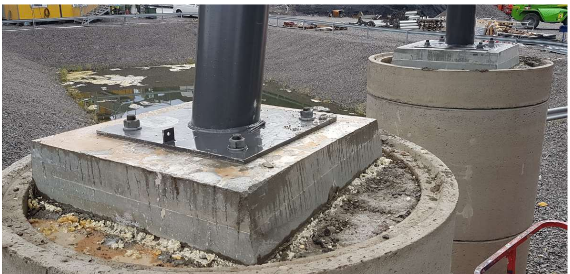
Kuva 14. Jalan alapää kiinnitettynä perustuspulttiryhmään sekä jälkivalu.
