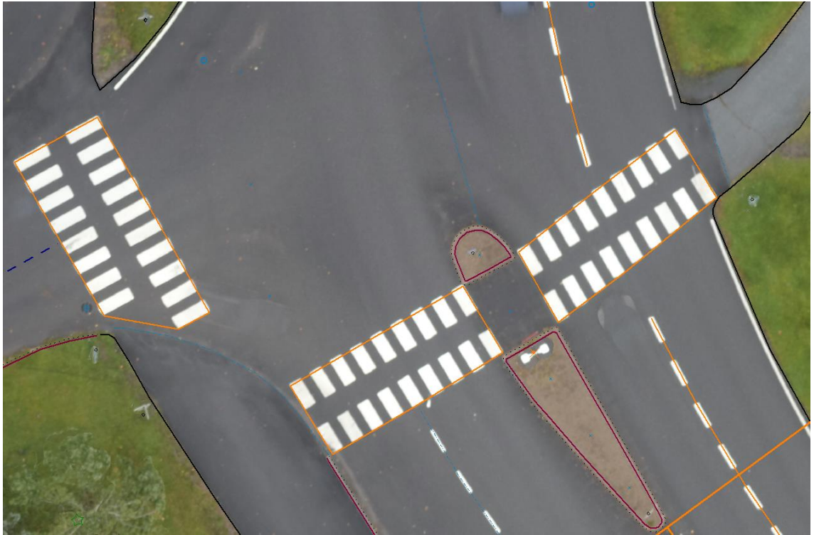
Kuva 26. Ajoratamaalaukset, kanttikivet sekä suojatiet ovat paikoillaan
