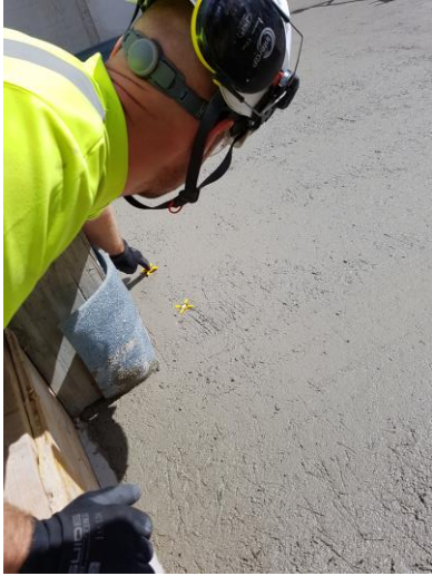
Kuva 3. Antureiden asennusta betonivaluun
