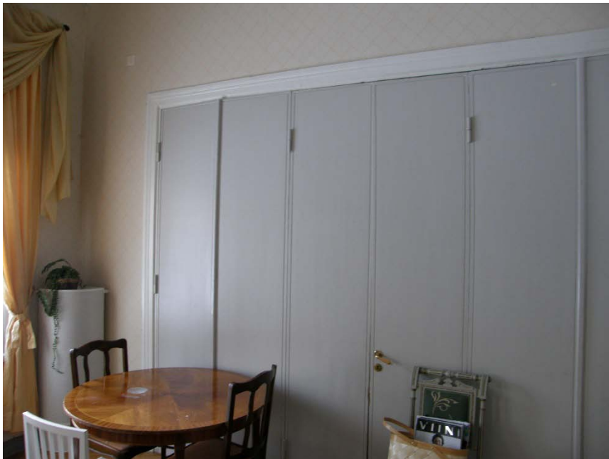
Kuva 14. Ensimmäisen kerroksen salien välinen taiteoviseinä
