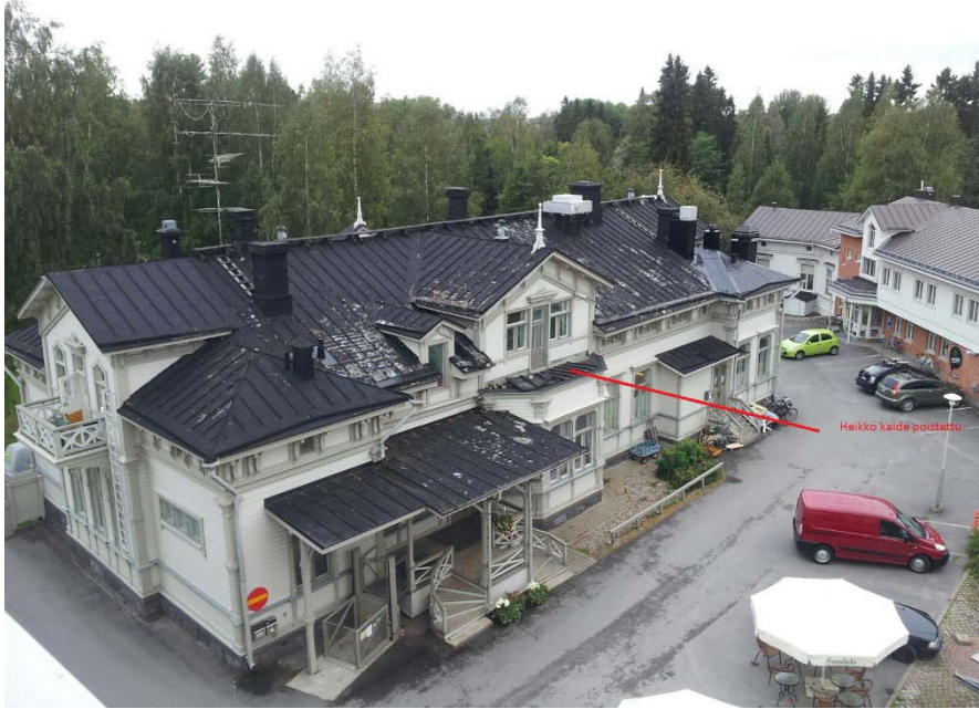
Kuva 10a. Kattoparveke, jonka heikko kaide on poistettu.
