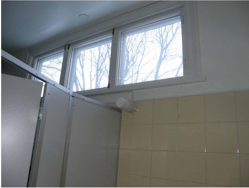
Kuva 13. Ensimmäisen kerroksen wc:n jakoseinä
