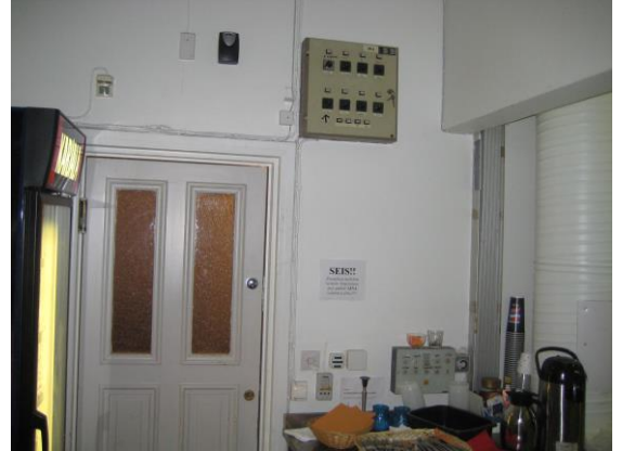
Kuva 2 Nykyiset valaistuksen ohjauslaitteet
