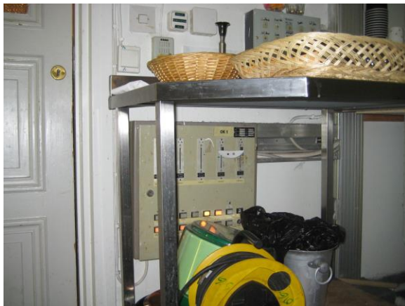
Kuva 3. Valaistuksen nykyinen säätokekeskus.
