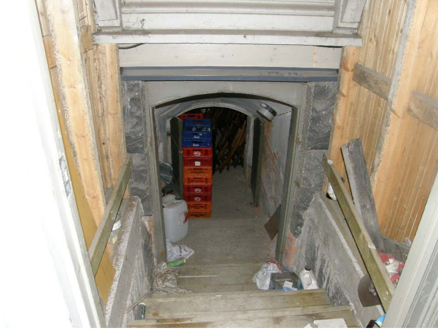
Kuva 1. Kellarin sisäänkäynti rakennuksen länsipäädyssä
