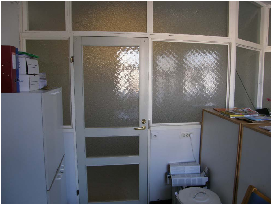
Kuva 12. Toisen kerroksen lasiväliseinä
