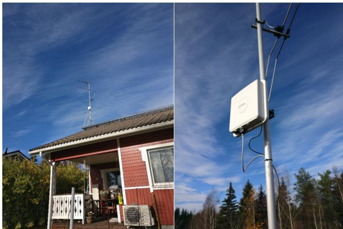
Kuva 40. ZyXEL LTE7460-M608 -modeemin asennus 2.11.2019
