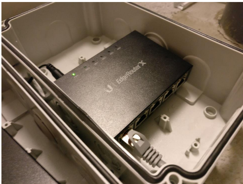
Kuva 53. Ubiquiti Edgerouter X -asennus
