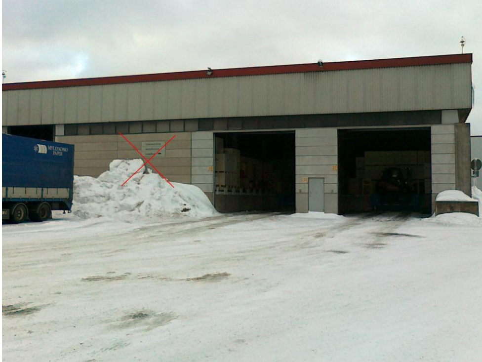
Kuva 10. Kartonkitehtaan tuotevaraston autonlastauspaikat. Kuvaan on rastilla merkitty uuden autolastaussillan paikka.
