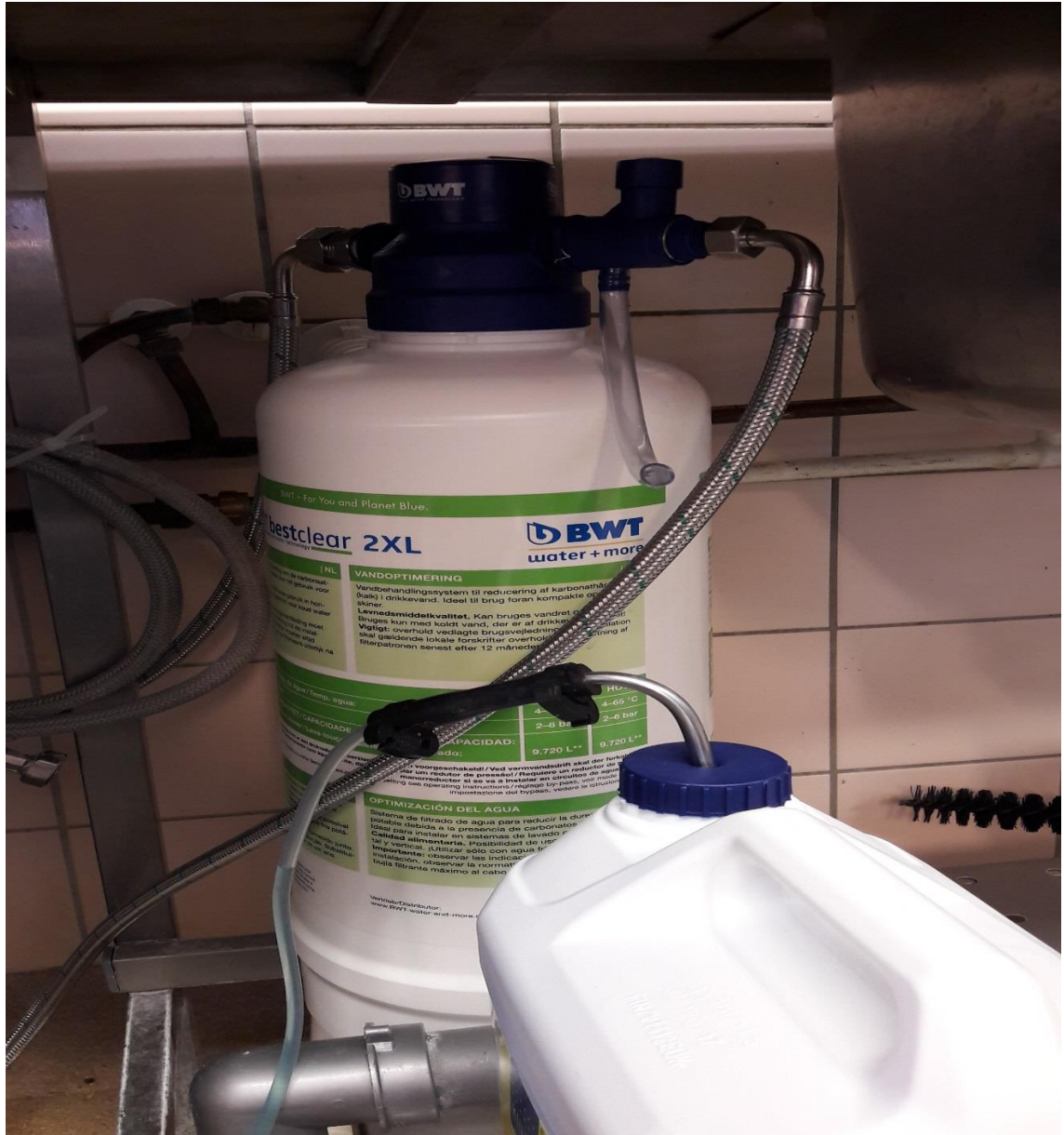
Kuva 12: Vedenpehmittin Bestclear 2XL asennettuna tiskipöydän alle.
