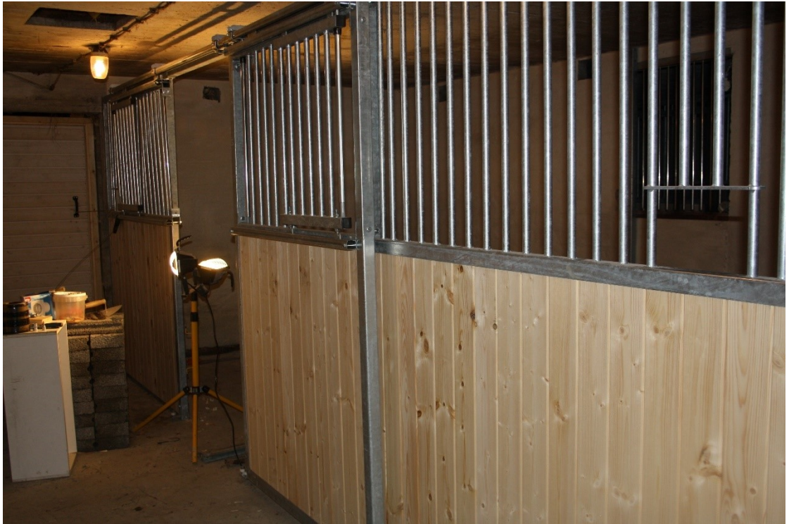
Kuvio 4. Vanha navetta, oviaukko muurattu ikkunaksi ja karsinat rakennettu
