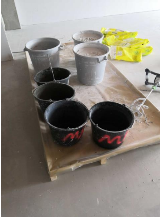
KUVA 3. Varoallas vesiastioiden alla Vatialan koulun työmaalla (9)
