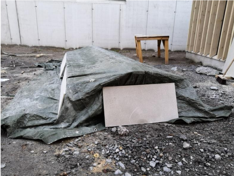
KUVA 1. Oikeaoppinen suojaus tuuletusrimalla ja peitteen kallistuksilla
