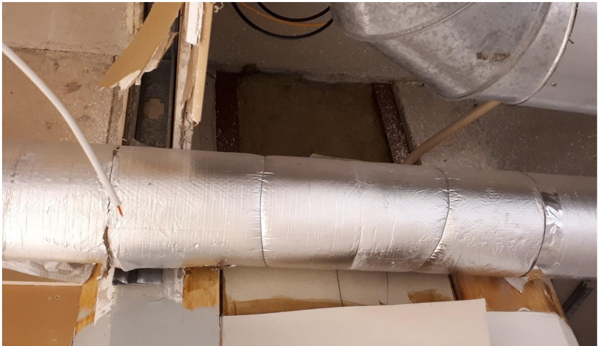
Kuva 4. Kaksoispilarin yläosa suljettu mineraalivillalla, alkuperäinen toteutus.
