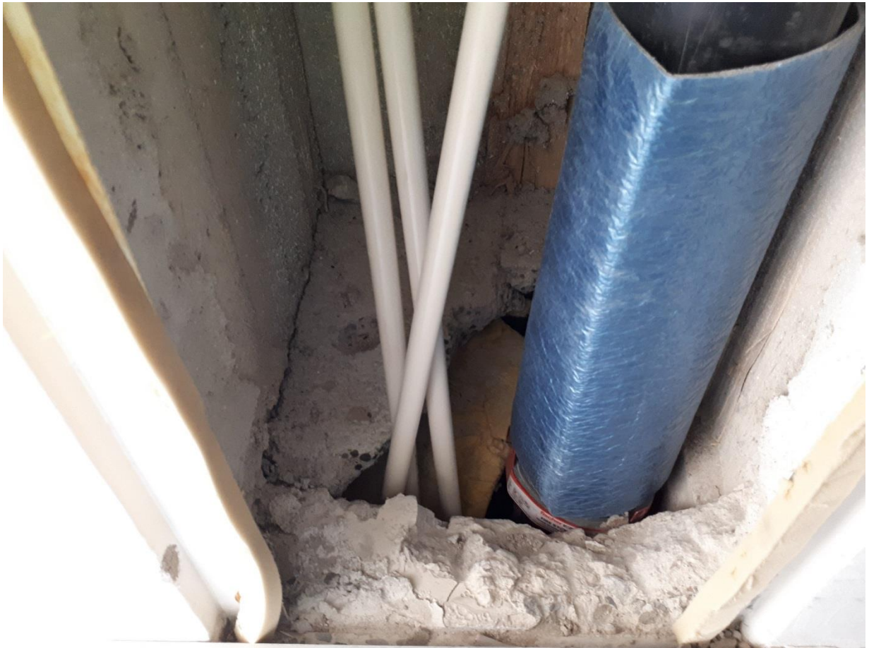
Kuva 2. Havainnekuva uuden viemärin läpiviennistä ja vanhan palokatkon hajoamisesta. Sininen kuori viemäriputken päällä tulee asentaa tiiviisti putkea vasten, huom. kuva 3.
