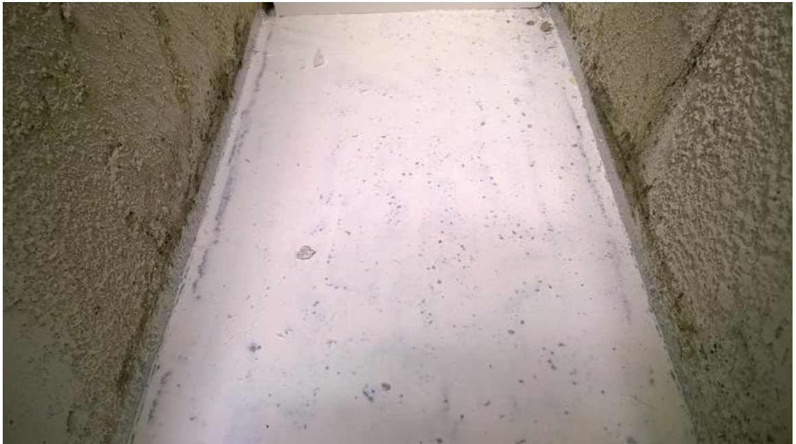
Kuva 5. TKR tiivistetty pilarin pohja, viimeinen tiivistekerros on valkoinen.
