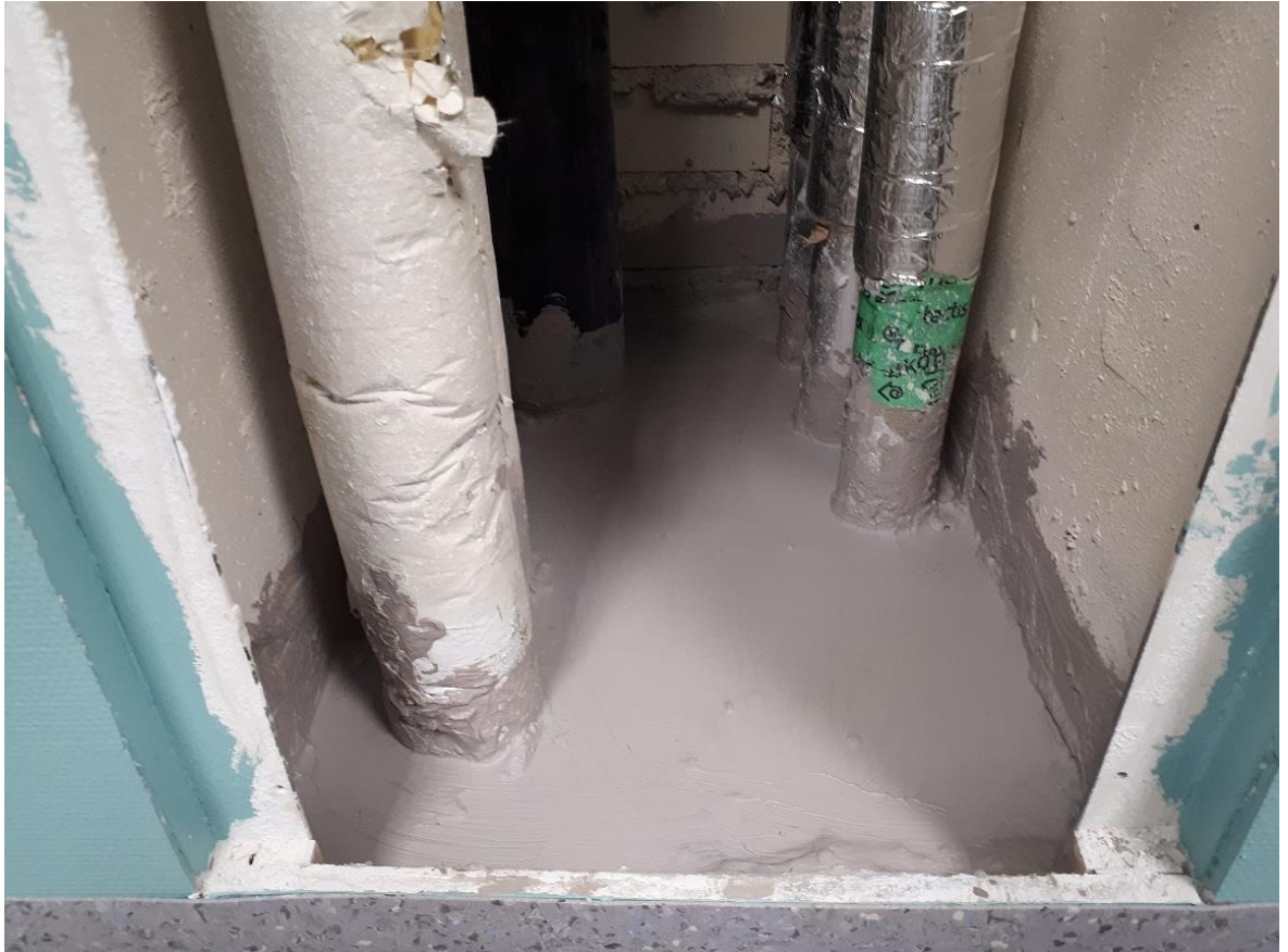
Kuva 9. Schönox HA-vesieristemassalla käsitelty palokatkon päällinen.
