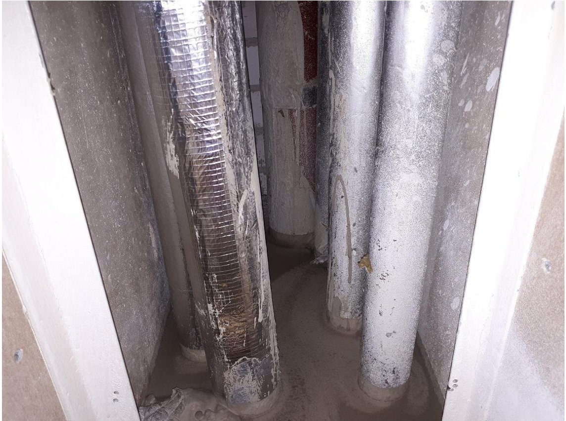
Kuva 7. Vaikeita paikkoja on myös, kahdeksan toiminnassa olevaa läpivientä.
