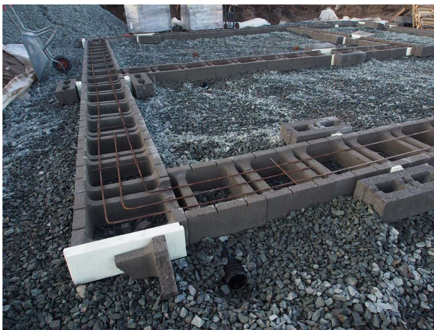
Kuva 15. Anturaharkot raudoitettuina valamista vailla, alareunassa talotekninen varaus (Repo 2019).
