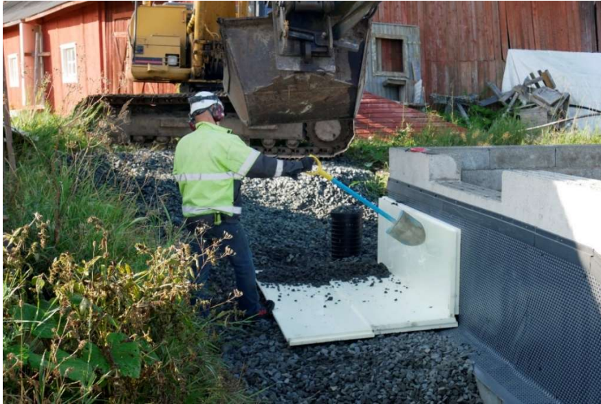
Kuva 20. Ulkopuolen routaeristyksen asennus (Repo 2019).
