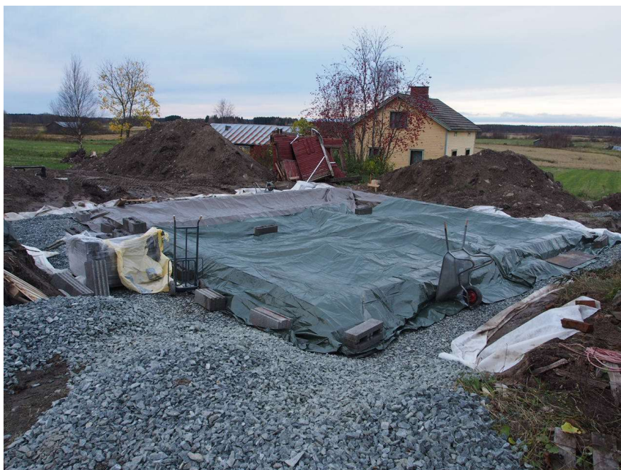
Kuva 17. Anturamuottivalu kuivumassa sääsuojattuna (Repo 2019).
