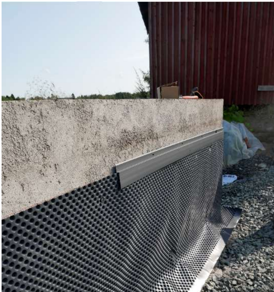
Kuva 19. Patolevy vedeneristyksen suojana (Repo 2019).
