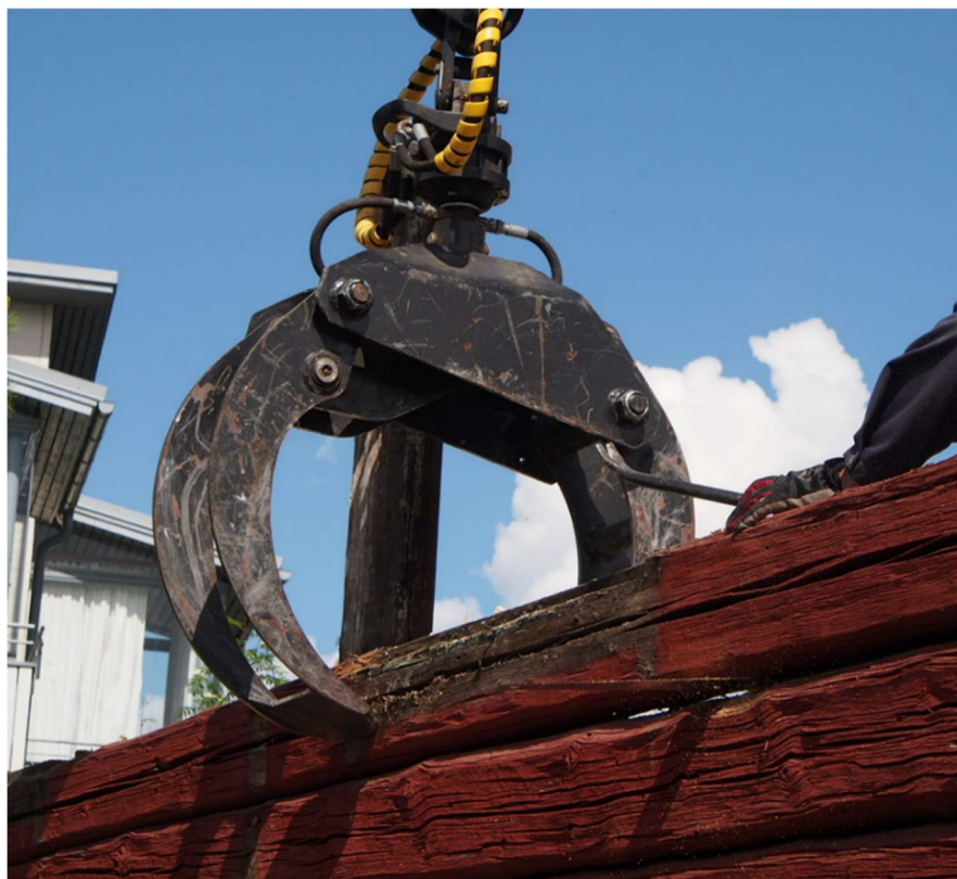
Kuva 11. Kiilatun hirren tapituksen sahaus ja nosto kouralla (Repo 2019).
