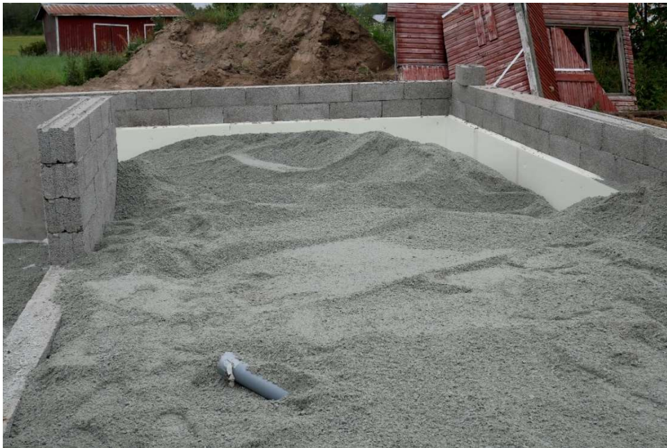
Kuva 21. Alapohjan täyttöhiekka ja viemäroinnin varaus (Repo 2019).
