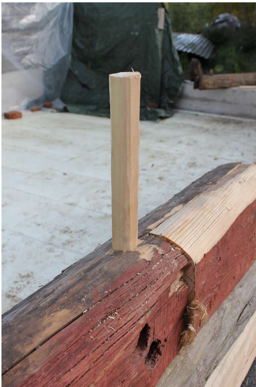
Kuva 24. Vaurioituneen hirren paikkaus (Repo 2019).
