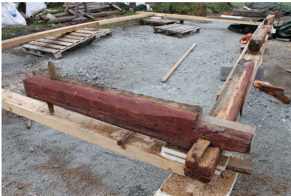
Kuva 22. Erillinen sovitusalusta vahoille hirsille (Repo 2019).
