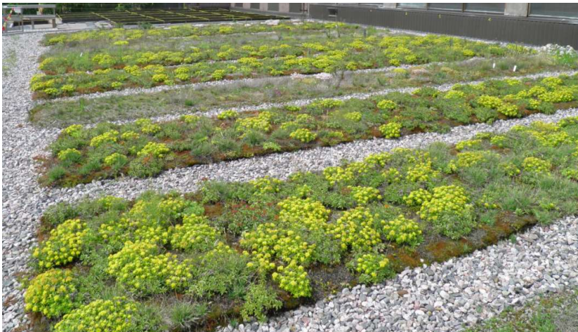
Kuva 1. Viherkaton hulevesien pidättymiskykyä on tutkittu Rakennusbetoni- ja Elementti Oy:n ja Helsingin yliopiston tekemissä koeviherkattokokeissa vuodesta 2013 alkaen. (Rakennusbetoni- ja Elementti Oy)
