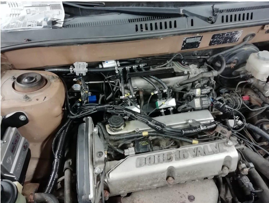
KUVA 25. Kaasujärjestelmän ohjainlaite ja johtosarja asennettuna
