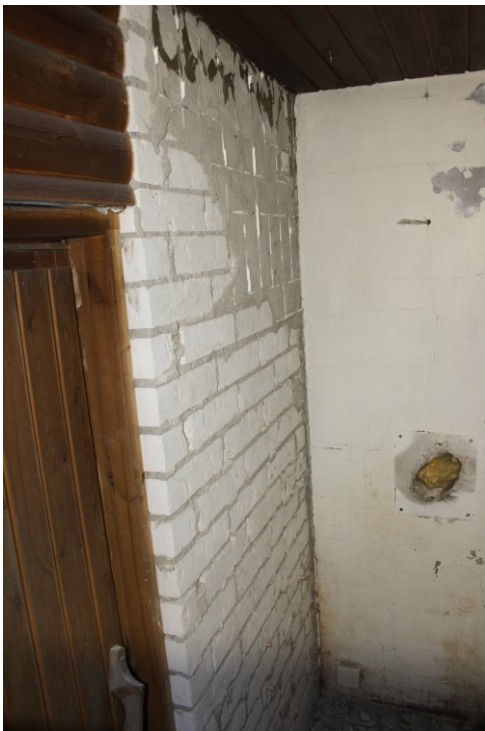
KUVA 6. Saunan seinä purettu tiilipinnalle
