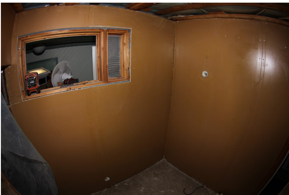
KUVA 13. Pesuhuone levytetty ja tartuntapohjattu
