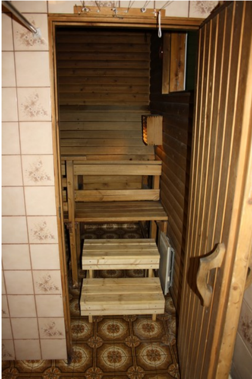
KUVA 2. Sauna ennen saneerausta
