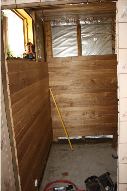
KUVA 8. Saunan seinien panelointia
