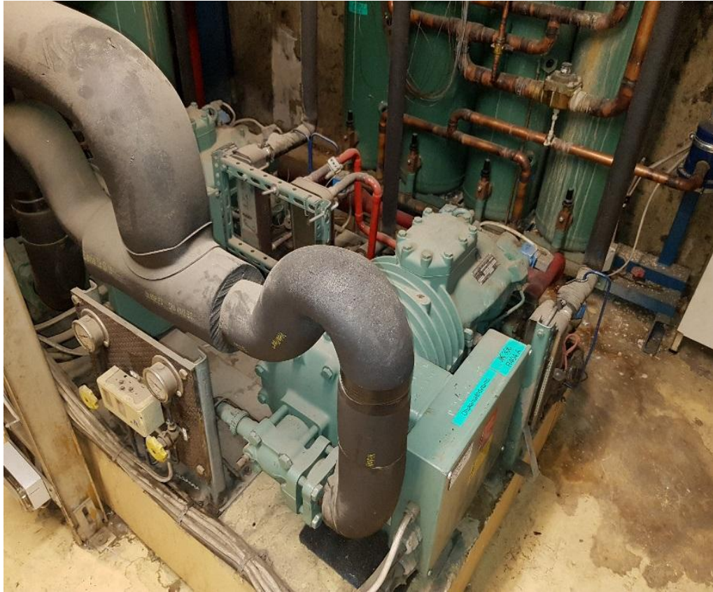
KUVA 6. ohukaisjäähdyttämön kompressorikoneikko
