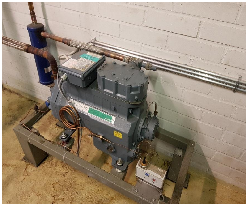
KUVA 14. dietikylmiön kompressorikoneikko
