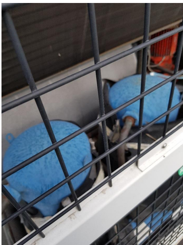
Kuva IV-jäähdytyksen rikkoutuneet eristeet.
