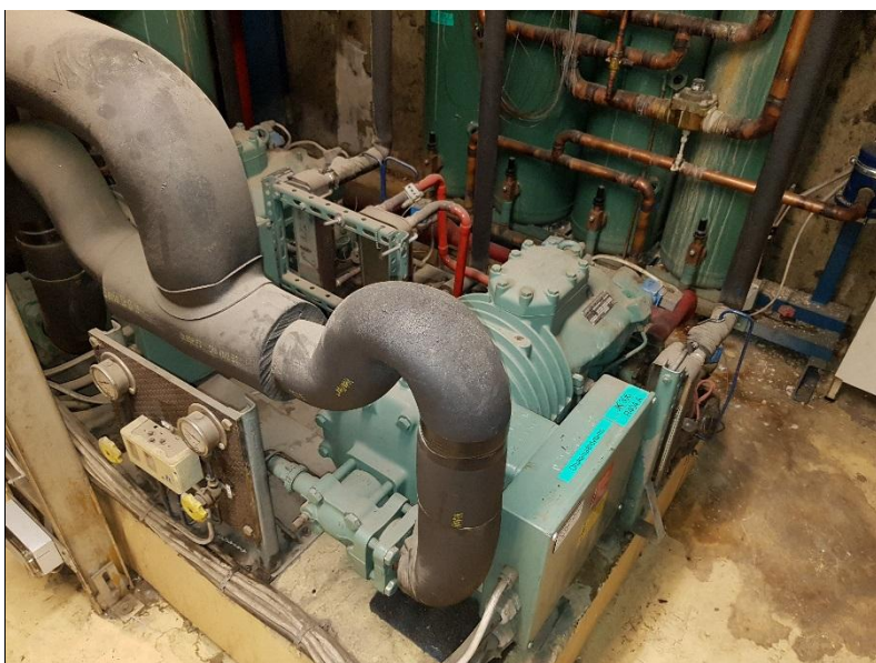
Kuva Ohukaisjäähdyttämön koneikko. Koneikko ei ole enää käytössä.
