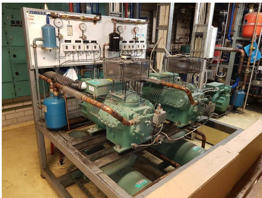
Kuva Spiraalin jäähdytyskoneikko, kylmäainemäärä noin 150 – 200 kg
