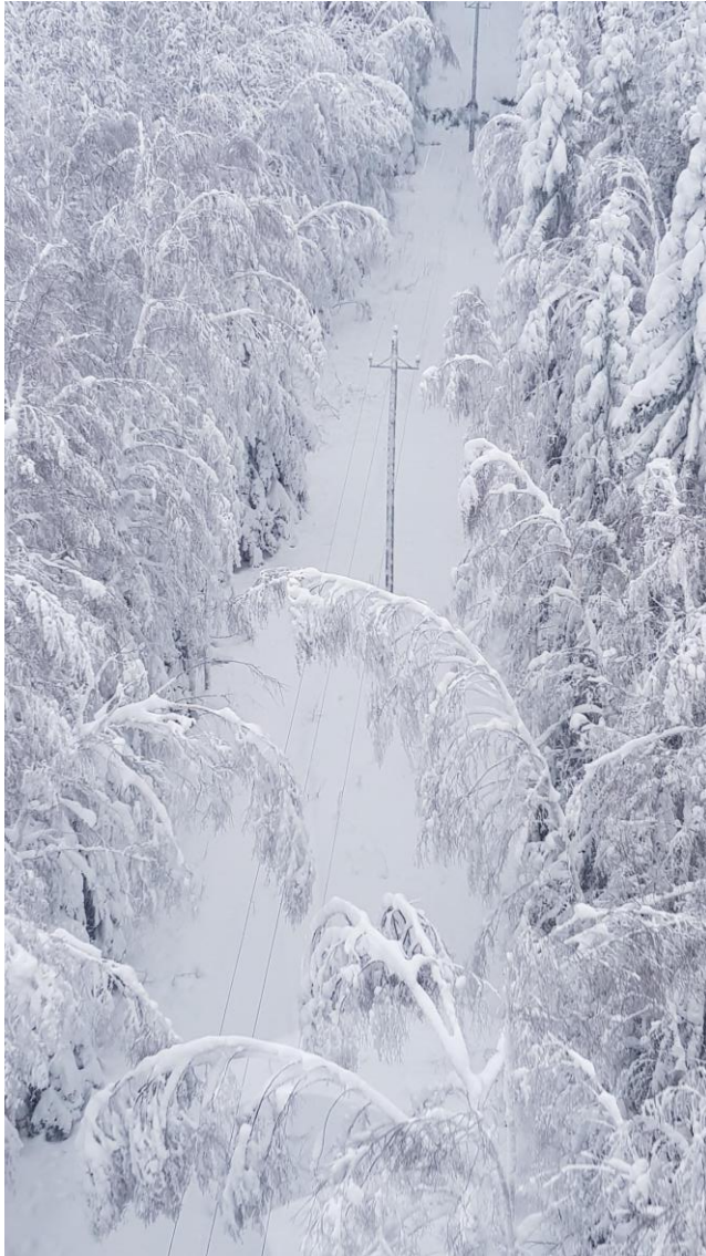
KUVA 1. Tykkylumen taivuttamia lehtipuita 20kV sähkölinjan päällä (Elenia Oy:n kuvapankki 2019)
