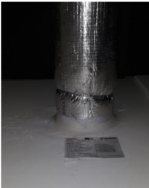
Kuva 2. Sprinkleriläpivienti, palokatkon materiaalina käytetty palokipsimassa.
