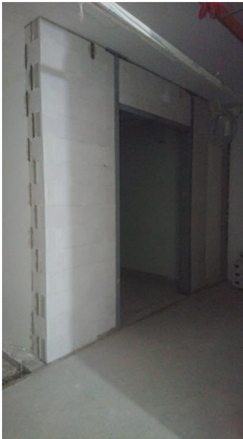
Kuva 1. UPE-palkit muuraustukena ovien kohdalla.
