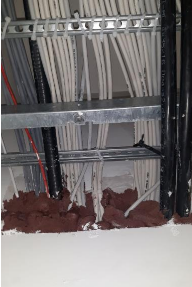
Kuva 4. Sähköläpivienti tehty Combo 2k, paisuvalla palokatko-vaahdolla.
