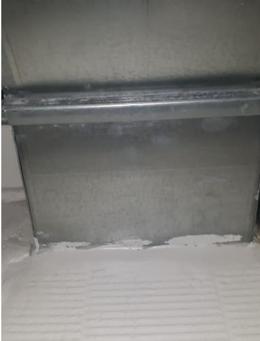
Kuva 3. 50 mm pinnoitettua palokatkolevyä ja ACR-paloakryyli.
