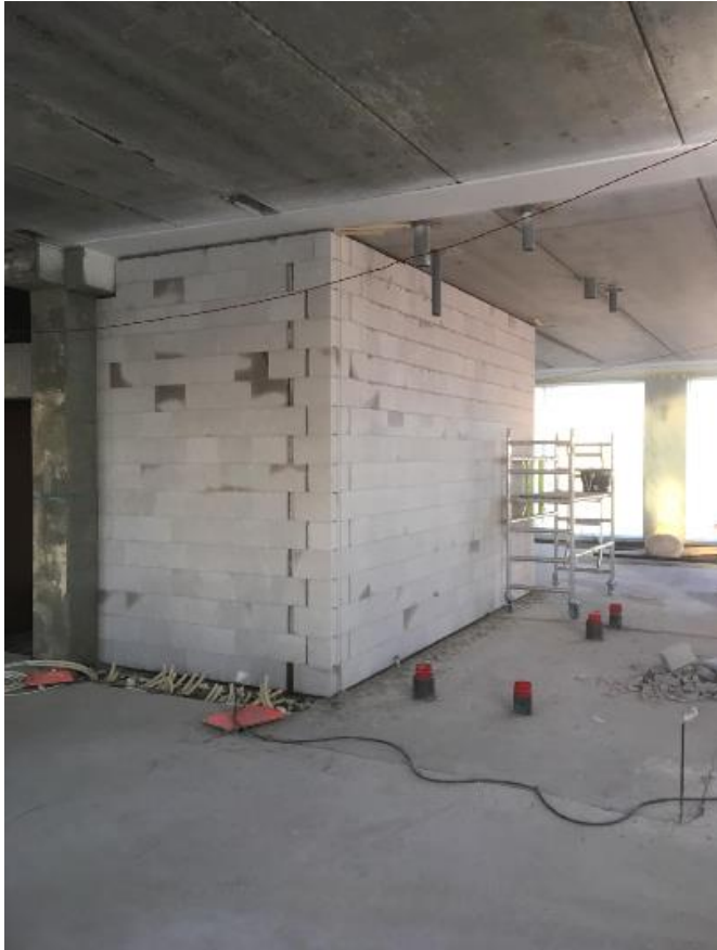
Kuva 7. Alumiininen purettava muurausteline.
