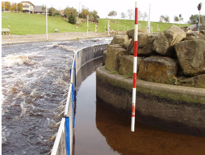
Kuva 3: Tilapäisen tulvasuojelurakenteen kokeilu (Rissanen 2008)
