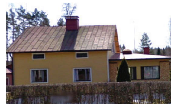
Kuva 87. Laajennusosan kattomuoto ja ikkunat eivät noudata perusosaa.
