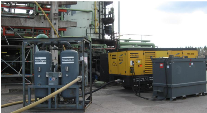
Kuva 13. LKII paineilmakompressori.
