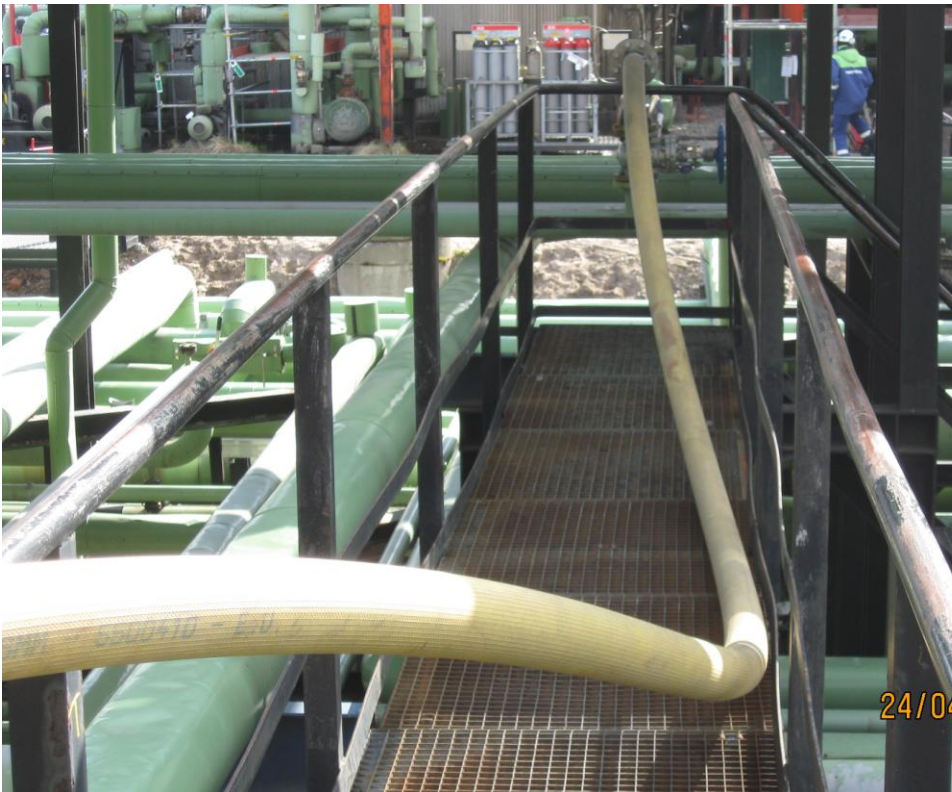
Kuva 16. Typpilaitoksen paineilmakompressorin liitos.
