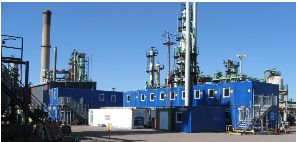
Kuva 10. Alkylointiyksikön seisokin aikaiset työmaatilat.
