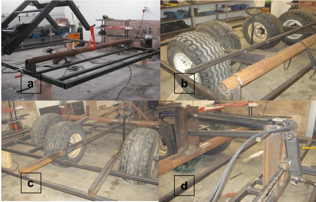
Kuva 7. Keskilohkon valmistuksen vaiheita: a) Noston vääntöputken asennus runkoon b) Telien kiinnitys vääntöputkeen c) Vinojen runkopalkkien hitsaus runkoon d) Nostomekanismin vakaintankojen valmistus.
