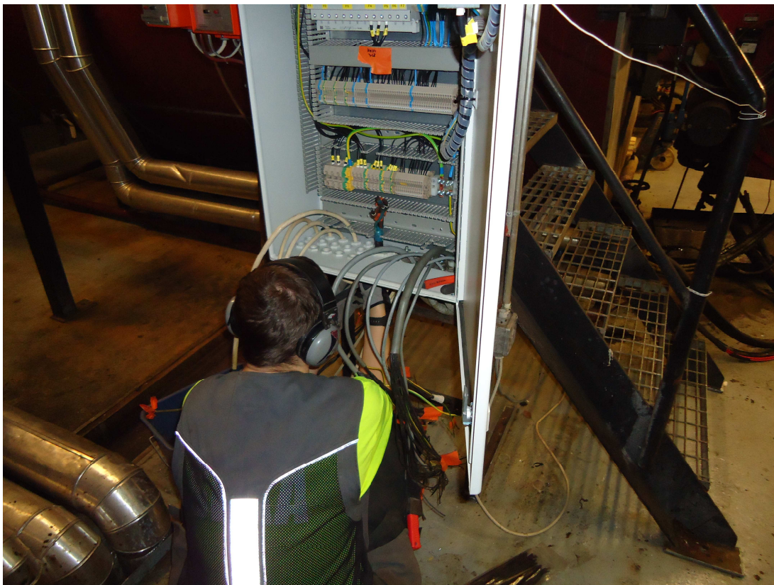
Kuva 27. Kaapeleiden takaisinkytkentä uuteen poltinkaappiin
