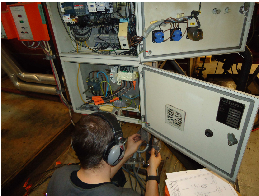
Kuva 26. Vanhan poltinkaapin kaapeleiden purkaminen
