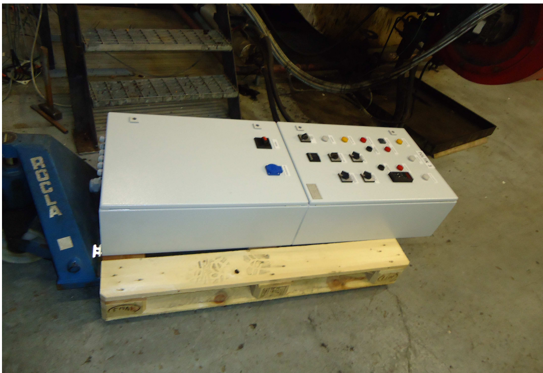
Kuva 9. Poltinkaappi ennen asennusta paikoilleen
