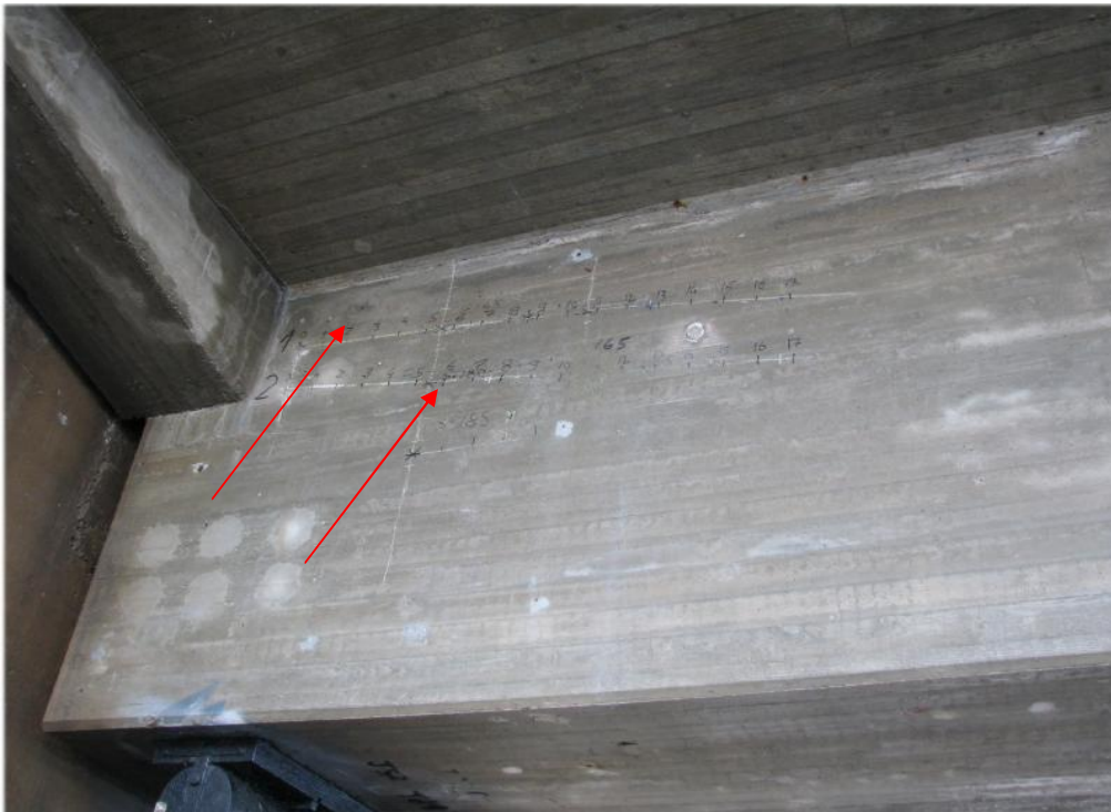
KUVA 8. Tutkimuslinjat on merkitty sillan jännepalkkiin.
