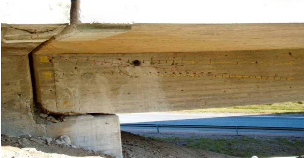
KUVA 9. Rakenne on avattu timanttikorauksella, Lieviön silta
