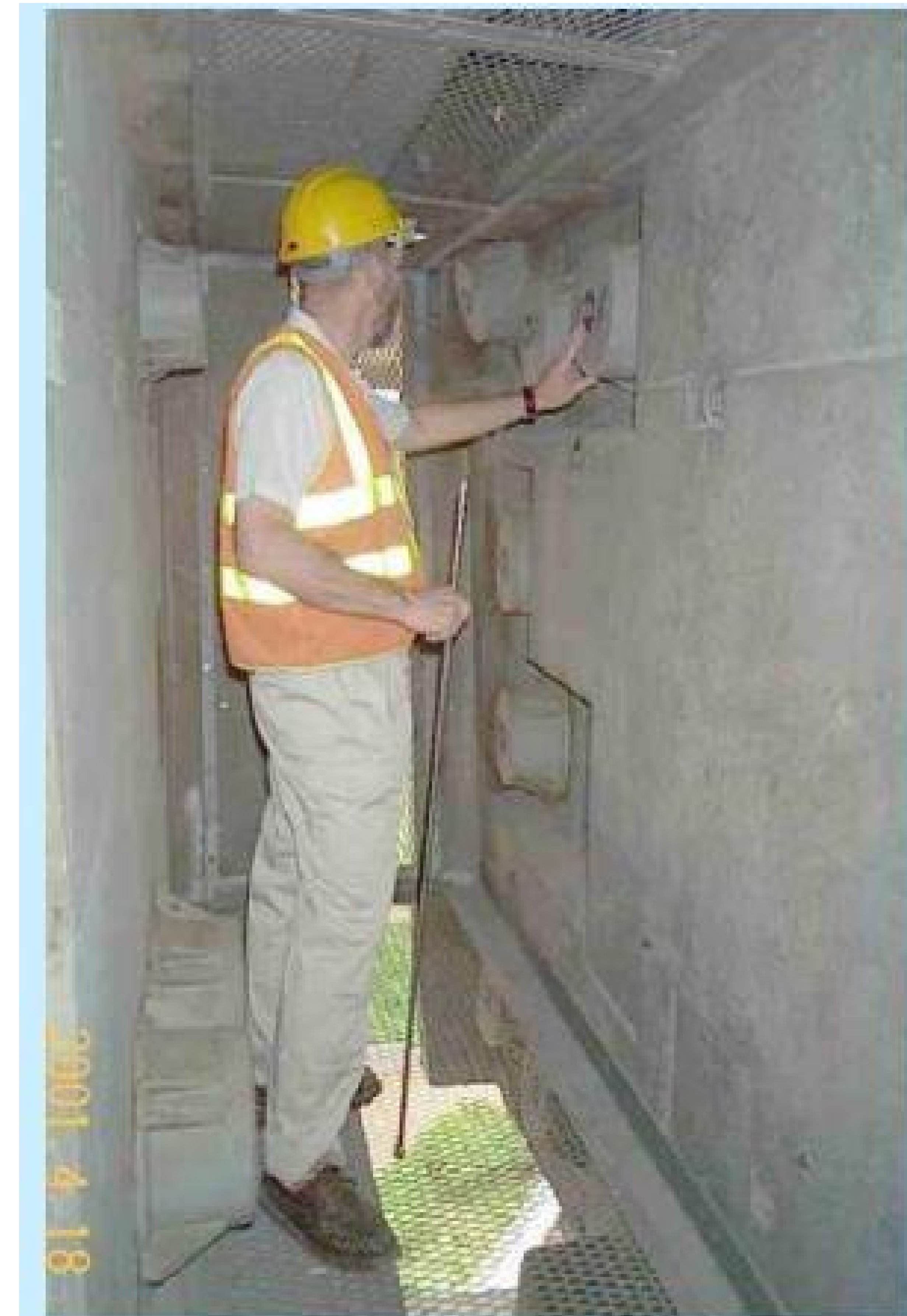
KUVA 11. TARKASTUSTILA JÄNNEPALKIN PÄÄSSÄ (Effective Inspection and Monitoring of Post-tensioned Structures and a Review of Preventative Maintenance Issues)
