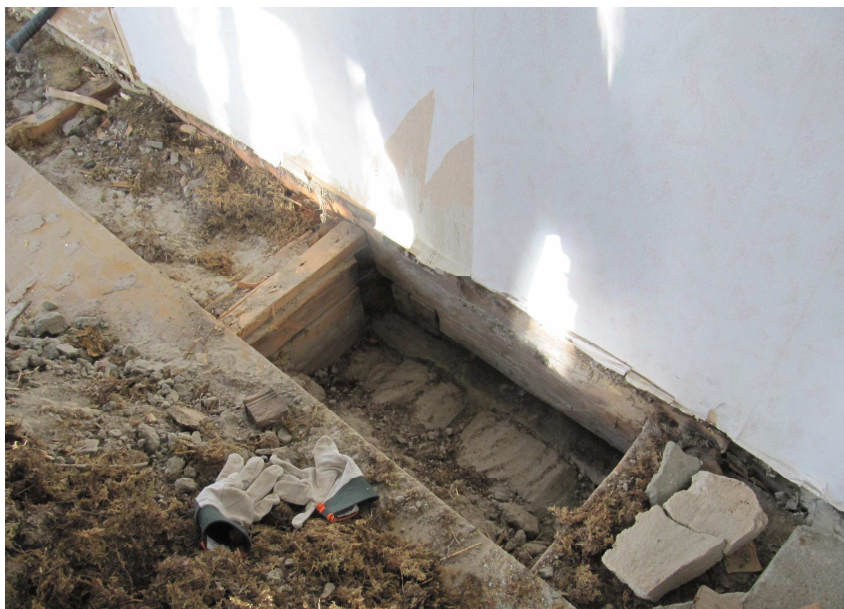
Bild 7. Insidan vid undersökning av golvbjälklag.
