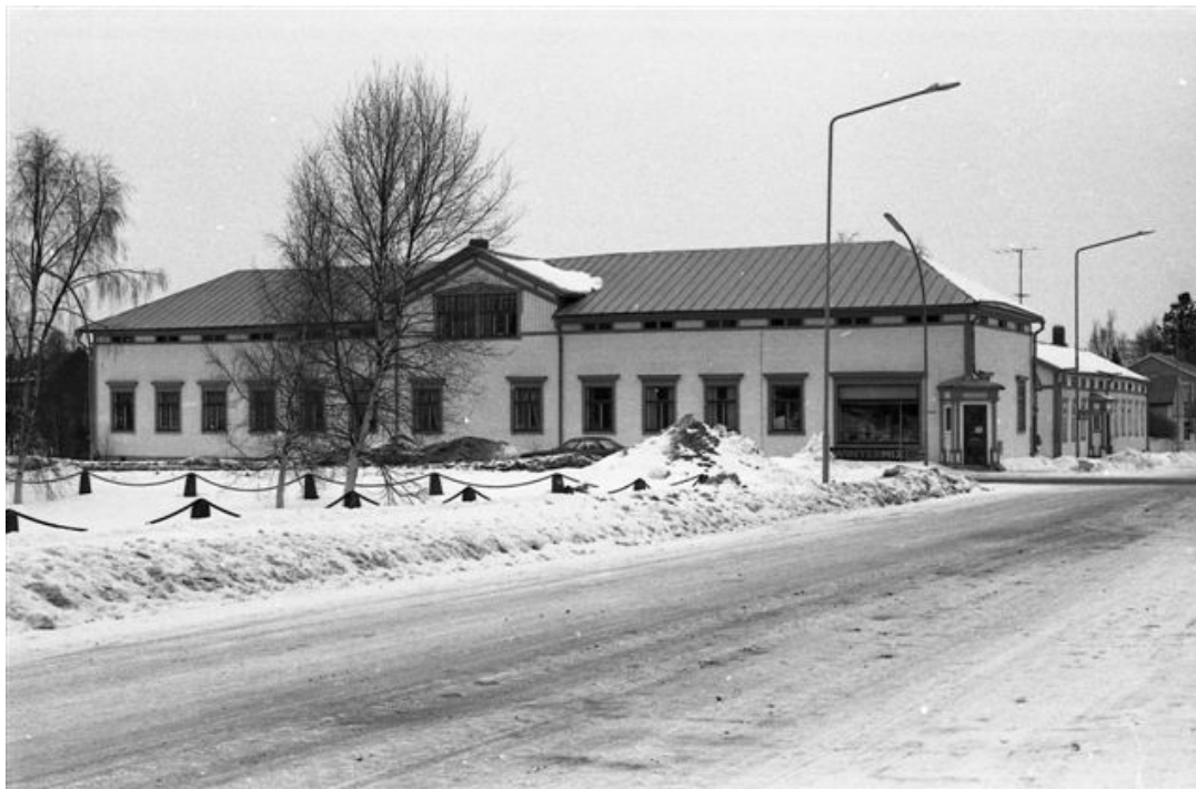
Bild 5. Byggnadens södra långsida år 1965. Vid denna tidpunkt var huset ännu i bra skick.
