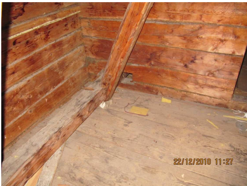
Bild 9. Från vinden där det kommer fram hur takkonstruktionen sitter ihop med mellanbjälklaget.
