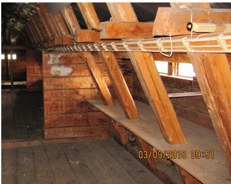
Bild 10. Från vinden där det visas att mellanväggarna sträcker sig lika högt som ytterväggarna och förstyrkar byggnaden på det sättet.
