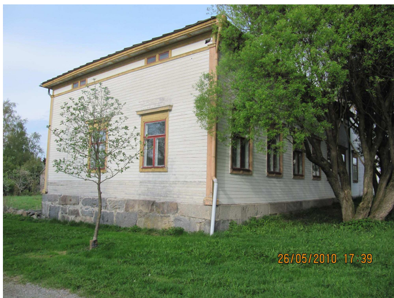
Bild 4. Byggnadens västra gavel där träden som kan vara orsaken till sättning syns.
