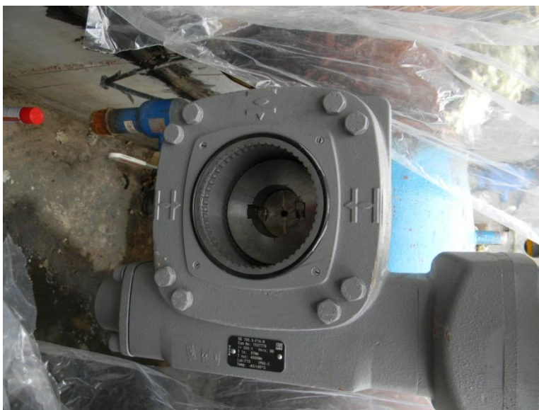
KUVA 18. Uusi vaihteisto kiinnitettynä venttiiliin
