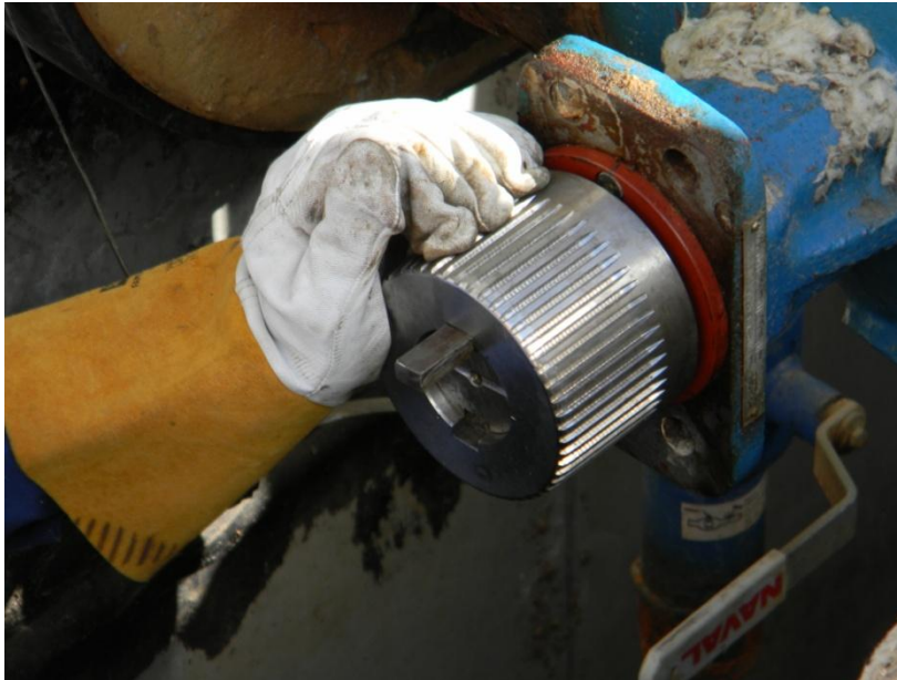
KUVA 16. Kytinkappaleen kiinnitys venttiilin karaan
