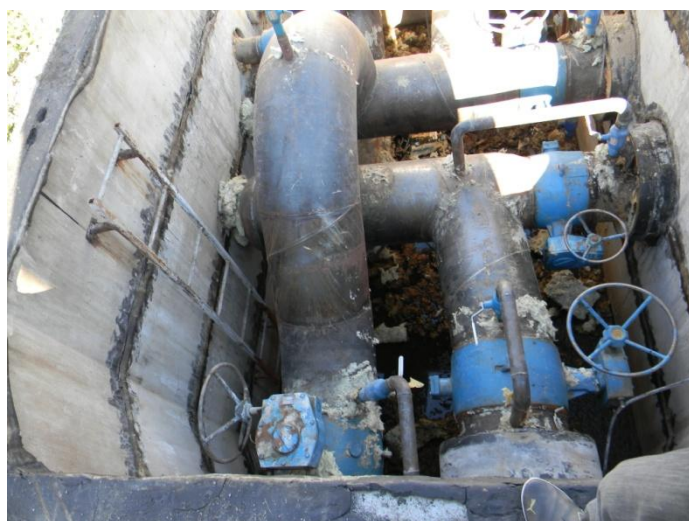
KUVA 13. Putkien eristeet poistettu ja kunto tarkastettu
