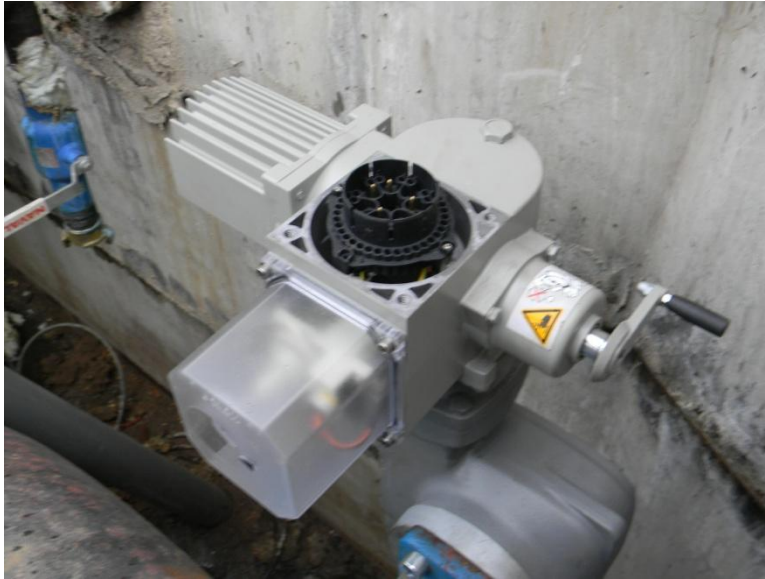
KUVA 19. Moottoriyksikkö kiinnitettynä vaihteistoon
