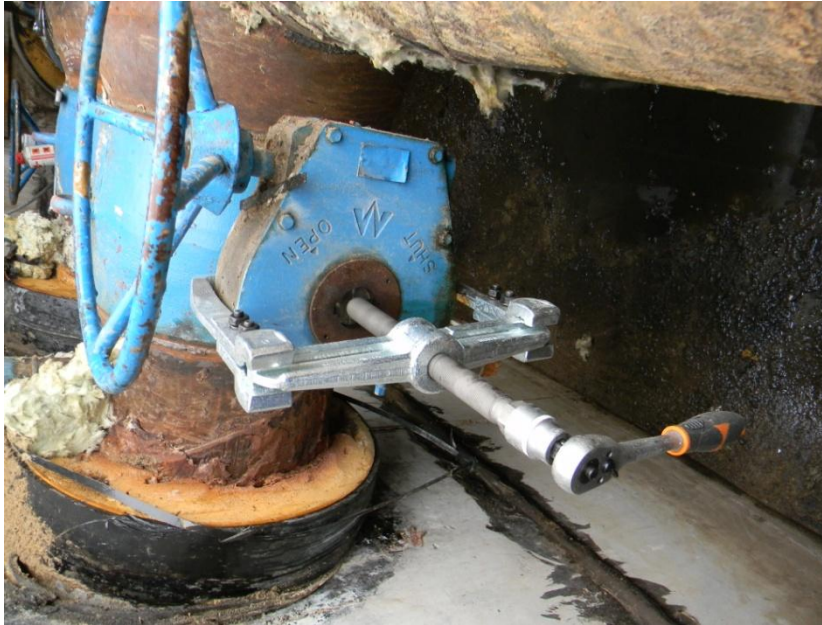
KUVA 14. Käsikäyttövaihteiston irrotus
