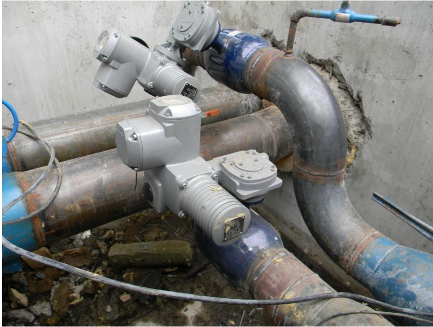
KUVA 26. Auma-toimilaitteet asennettuna
