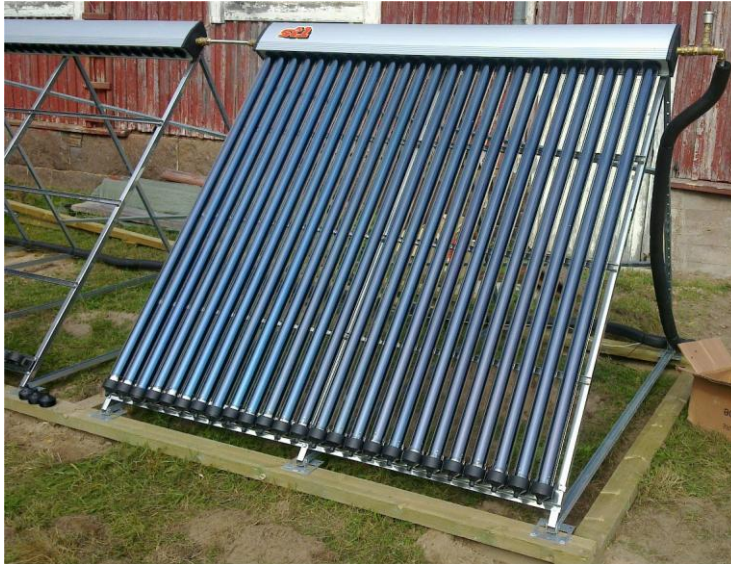
Kuva 5. Tyhjiöputkikeräinten asennus.
