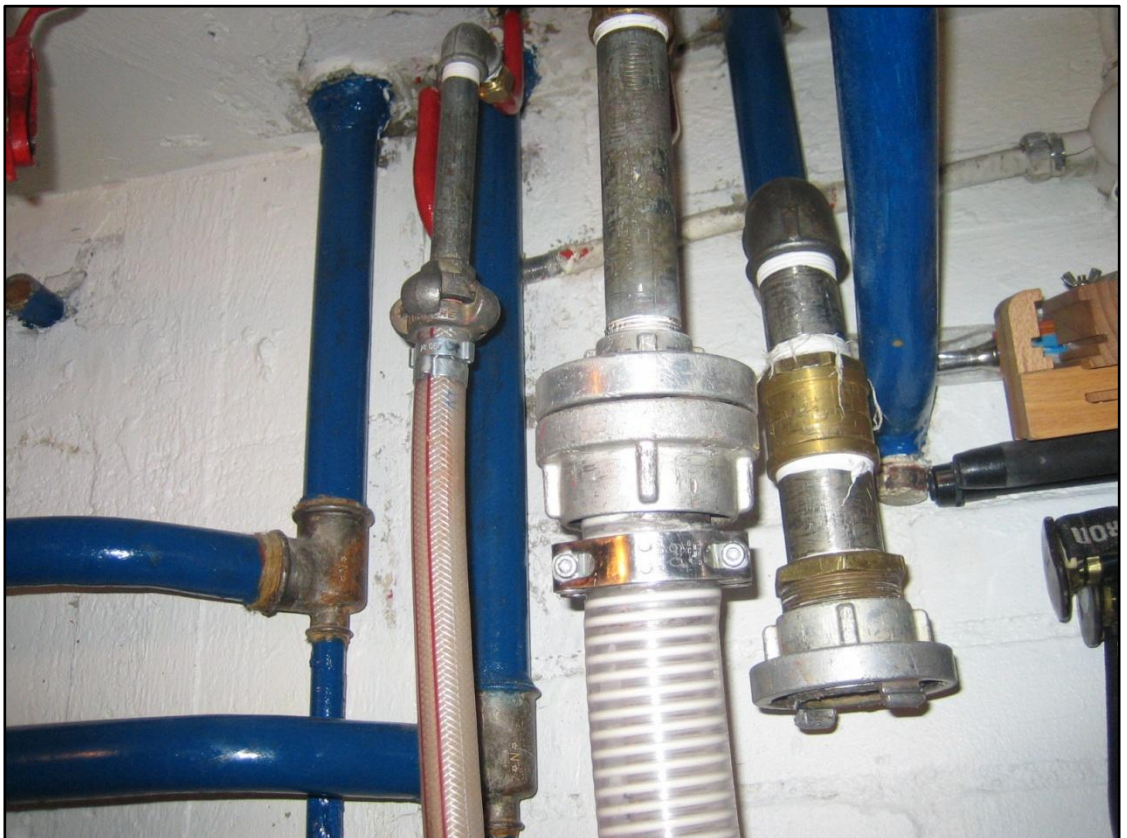
KUVA 9. Alipaineen liittäminen saneerattavaan putkistoon /6/
