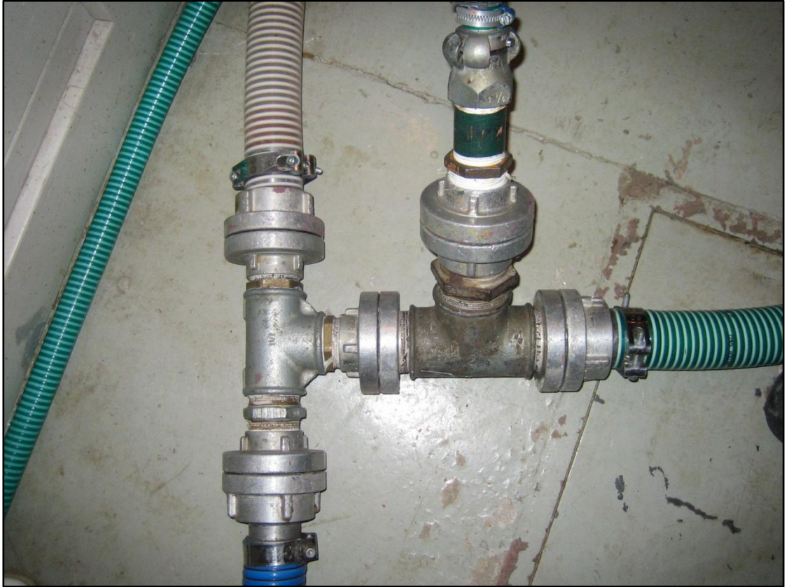
KUVA 8. Alipaineen jakaminen T-haaroilla /6/
