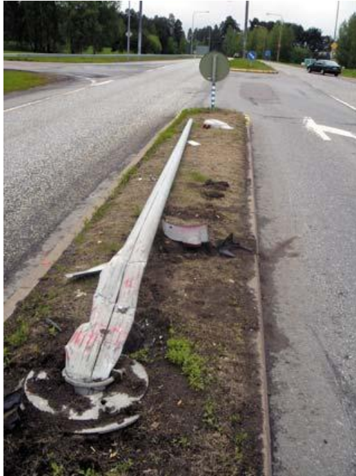
Kuva 5 Törmäyksessä ajoneuvon alle väistynyt metallipylväs. (Sähkö-Jokinen Oy n.d.)
