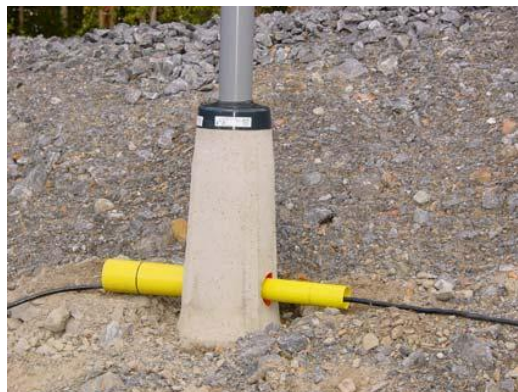
Kuva 4 Metallipylvään betoninen pylväsjalusta. (Sähkö-Jokinen Oy n.d.)
