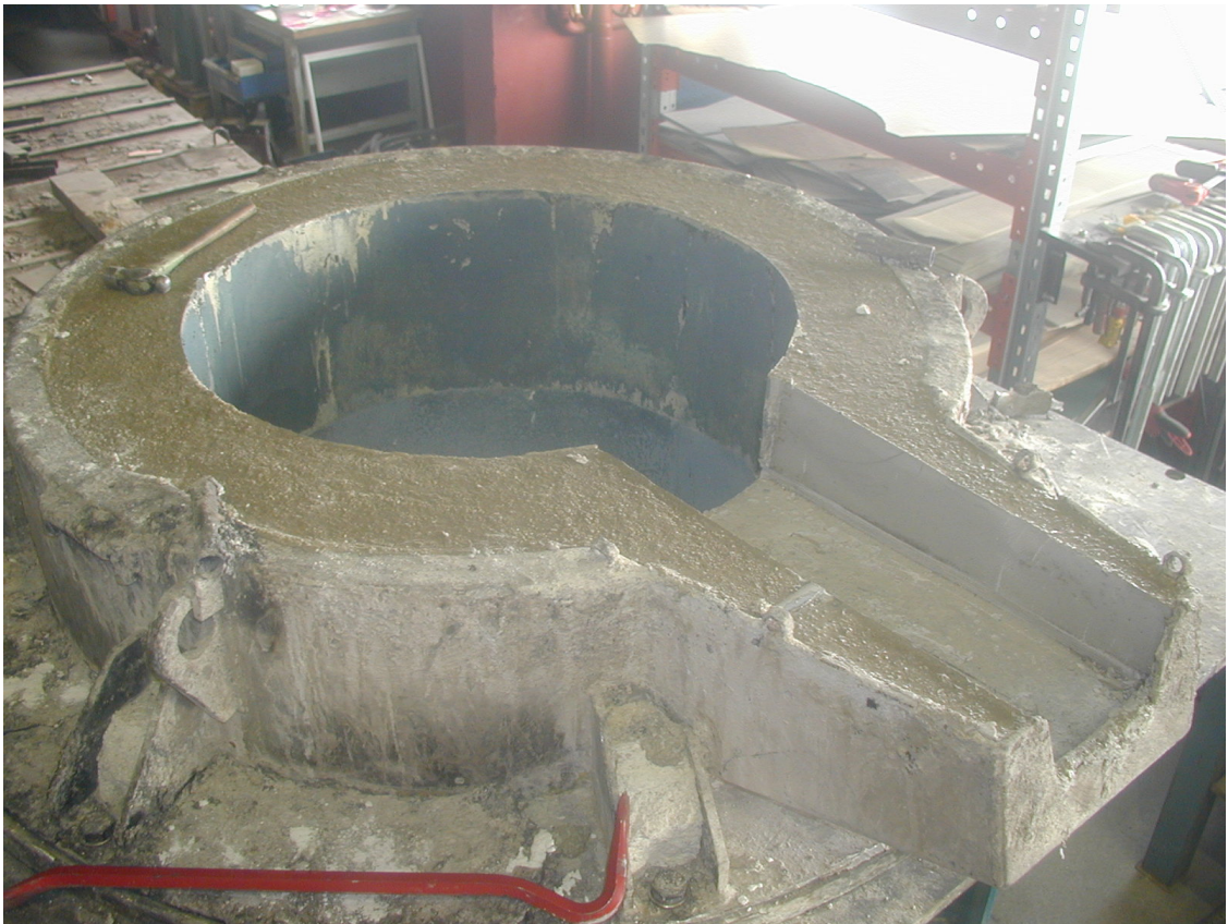
Kuva 6.18 Ylempi kelamuuraus ja kaatonokan valu
