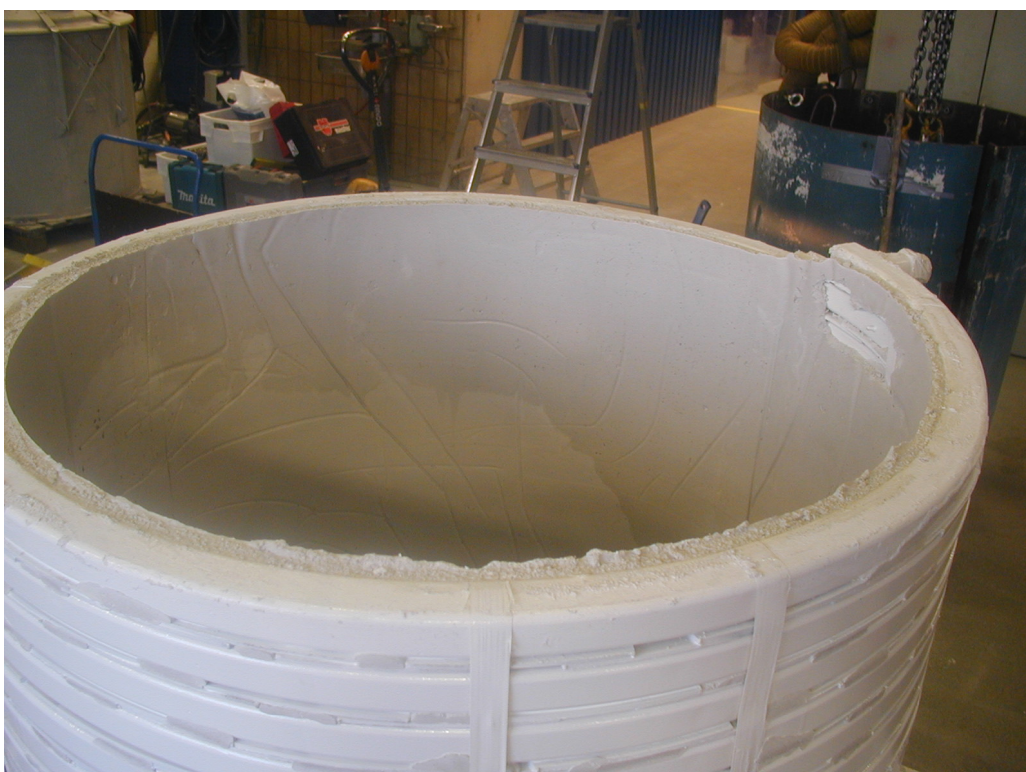
6.17 Huollettu kela valmiilla kelamuurauksella.
