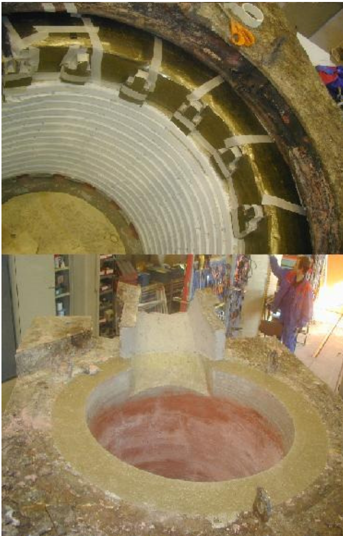
Kuva 6.15 Uuni ennen kela- ja ylempää kelamuurausta ja sen jälkeen
