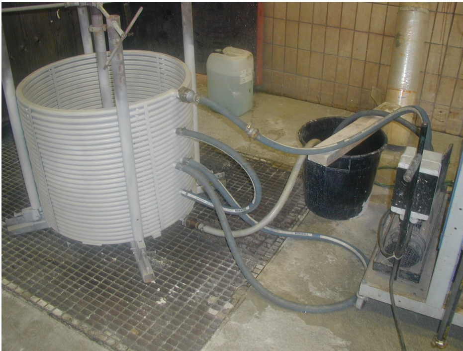
Kuva 6.12 Kelan vesikanavien puhdistus AP-3 kemikaalilla
