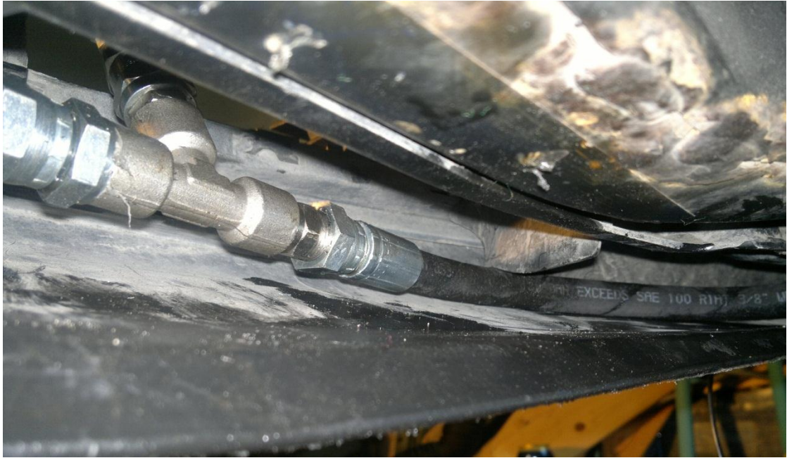
Kuva 22. Puskurin sisällä pumppu ja letkut asennusvaiheessa
