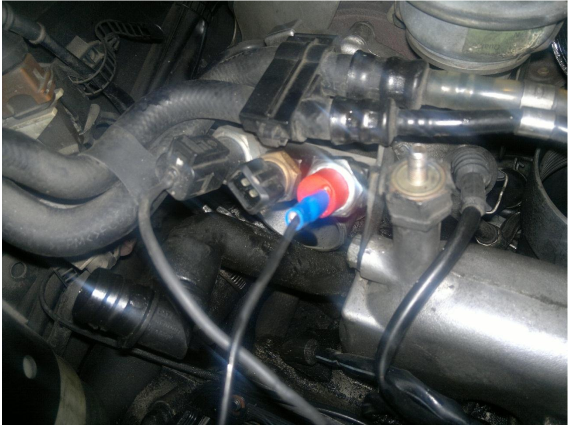
Kuva 28. Kuvassa kolmesta anturista oikeanpuoleisimpana painekytkin asennettuna turbon öljyputkeen
