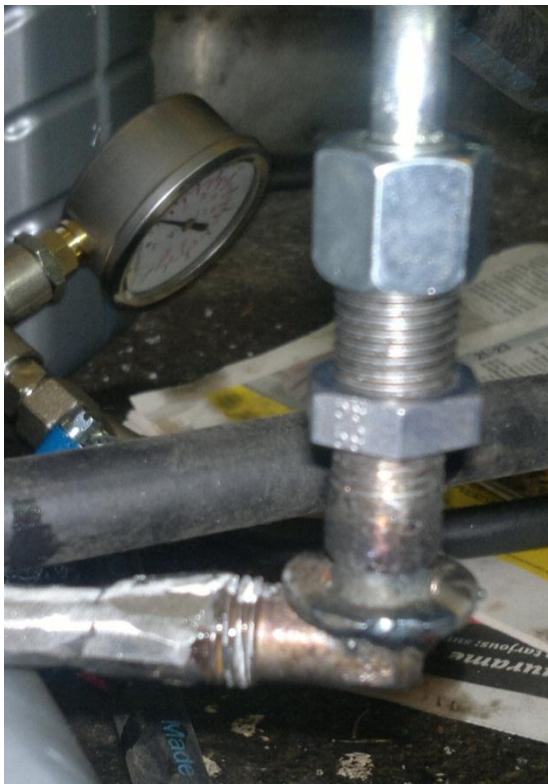
Kuva 11. Suihkuputki hitsattuna kiinni läpivientiin
