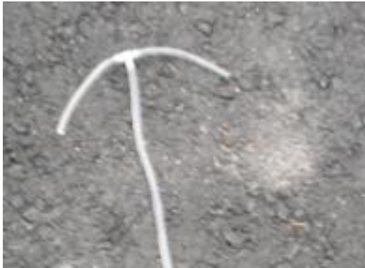
Kuva 7. Ulos asennettu putken pää.
