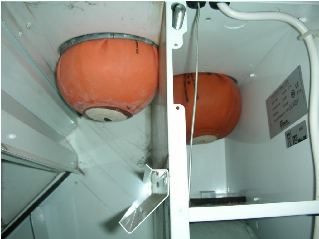
Kuva 3. Tulo- ja poistoventtiilit tukkiminen ilmanvaihtokoneesta.
