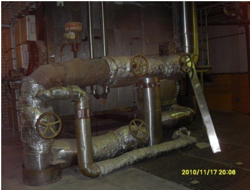
Kuva 2. Kuvassa 1 esitetty lämmönvaihdin rakennettuna.
