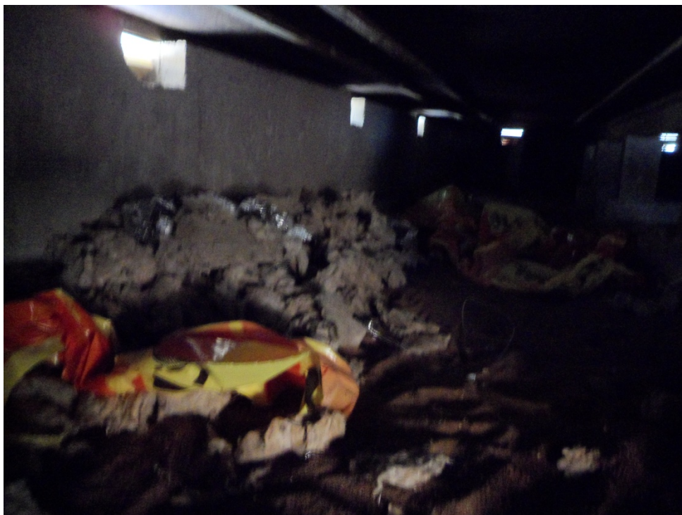
Bild2. Byggmaterial i krypgrunden.
