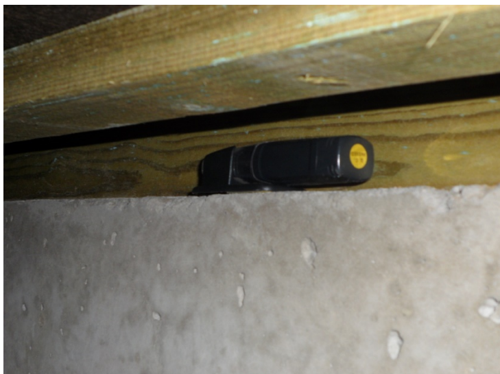
Bild 10. Mätare vid bjälklaget i kryputrymmet bredvid
