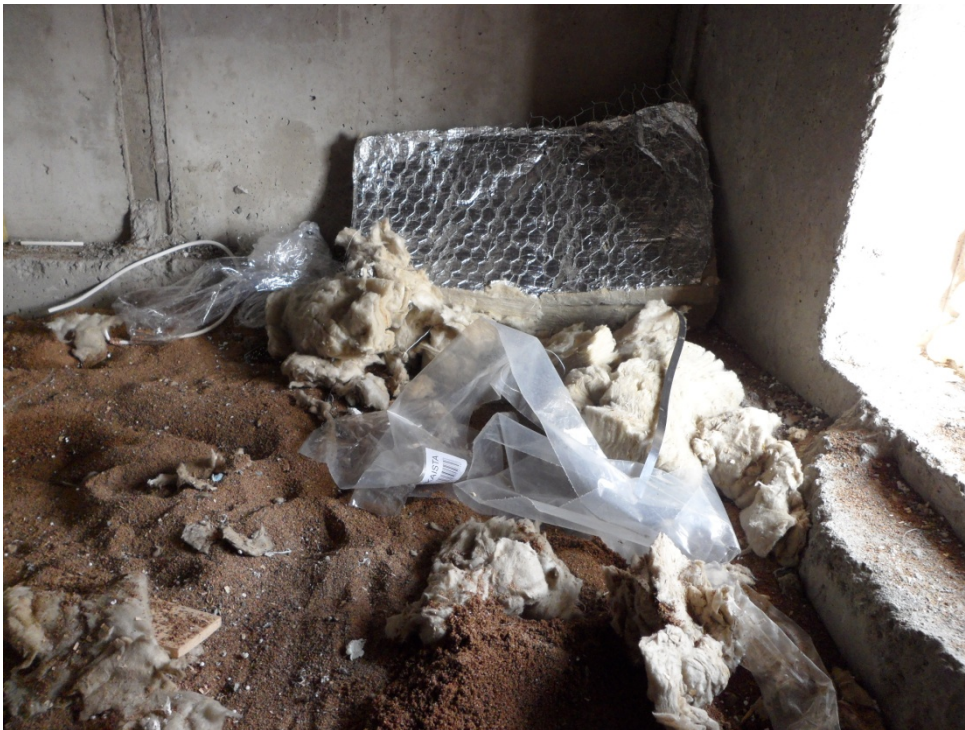
Bild1. En hel del byggmaterial finns kvar i krypprunden.
