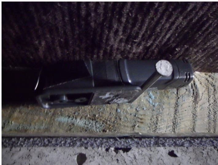
Bild 1. Mätare vid bjälklaget i krypgrunden
