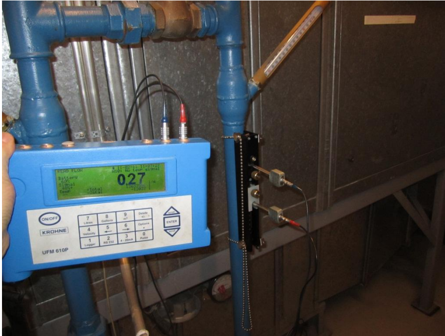
Kuva 19. Khronen ultraäänimittarilla virtaaman mittaus.
