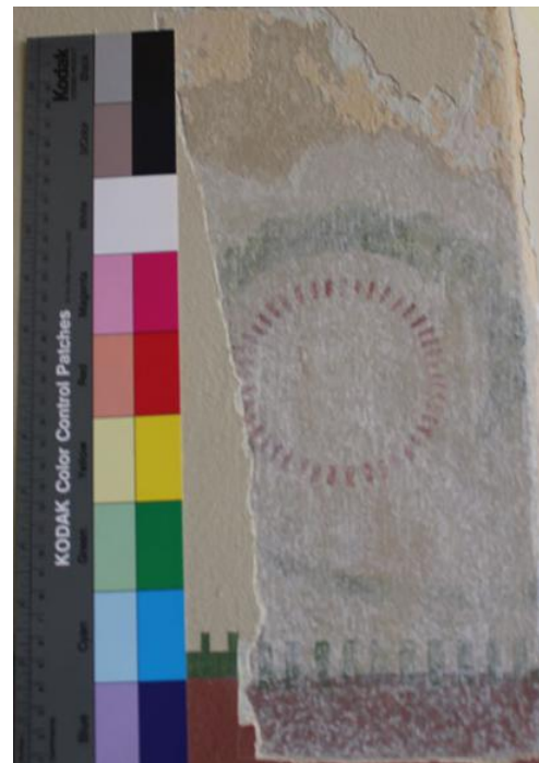
Maalaus 7. Aulan oviaukon karmien maalaukset. Pohjakuvassa vasemmalta puolelta.
