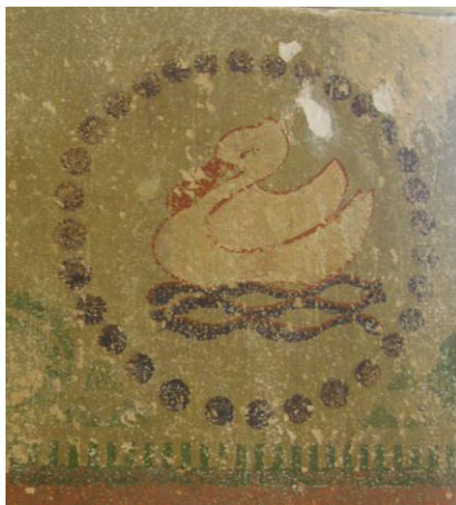
Kuva 18. Retusoitava alue ennen retusointia. Kuvassa näkyy valkoista silotetta sekä uudempia vaurioita.
