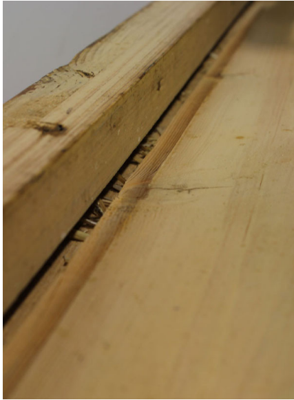
Kuva 20. Pohjalevy, jonka kutistuminen on tehnyt aukon eristyksen (Viitaniemi 2011).
