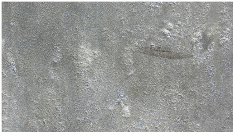
Kuva 11. Valkoista ruostetta sinkkipinnalla (Viitaniemi 2011).
