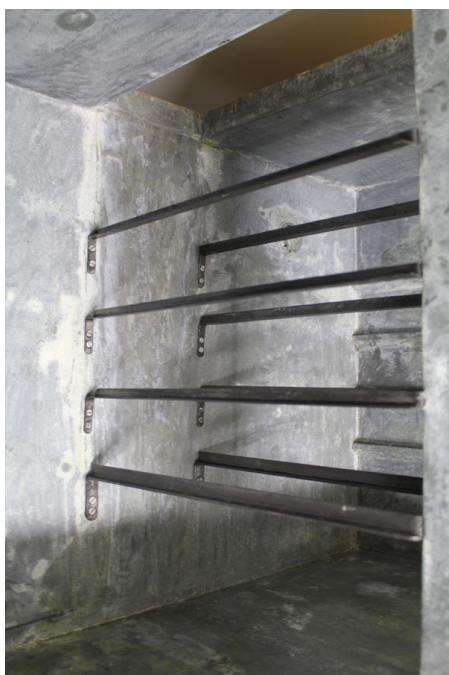
Kuva 25. Jäälohkarekaappi hyllylevyjen kannattimet restauroinnin jälkeen (Viitaniemi 2011).
