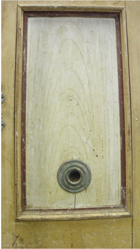
Kuva 16. Kulunut ja kellastunut pintakäsittely (Viitaniemi 2011).
