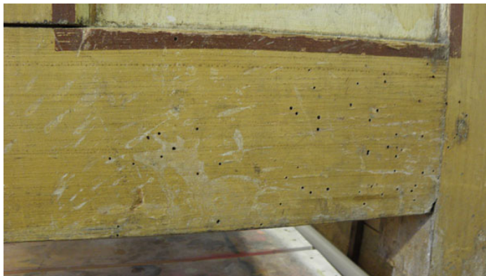
Kuva 19. Tupajumin aiheuttamat lentoaukot (Viitaniemi 2011).
