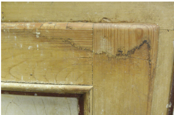
Kuva 18. Osa ovien pintakäsittelystä on kulunut kokonaan pois (Viitaniemi 2011).
