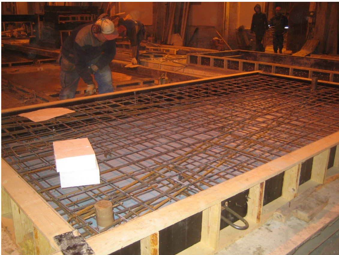
Kuva 2. Parveke-elementin muotti ja raudoitus
