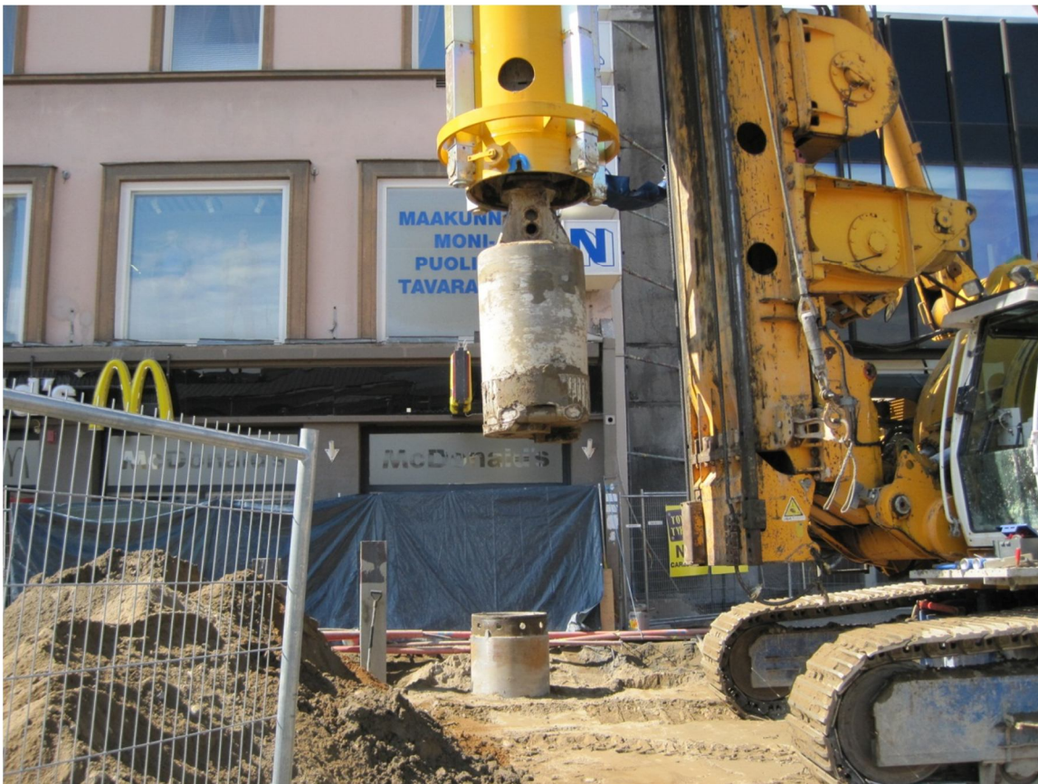
Kuva 6. Puhdistuskauha kiinnitettynä paalutuskoneen Kelly-tankoon. Kuva: Risto Savolainen 2010
