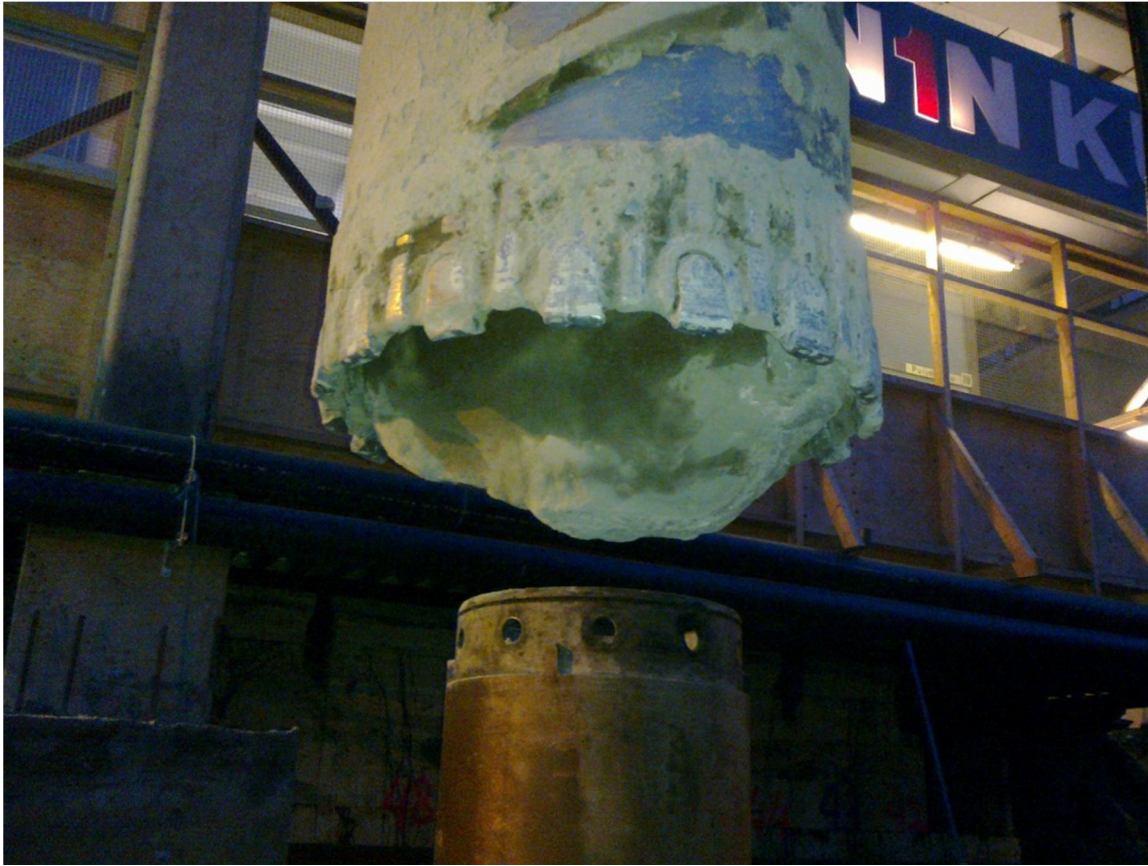
Kuva 31. Sydänkairalla paalukaivannosta nostettu kivi. Kuva: Niko Asikainen 2010
