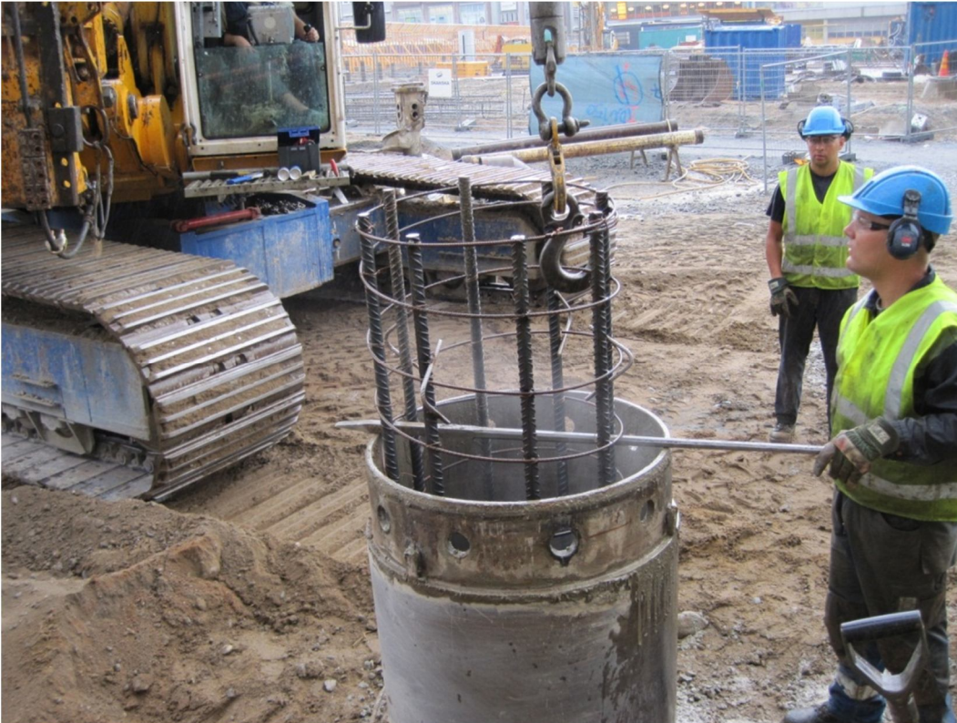
Kuva 13. Raudoitteen laskeminen paalukaivantoon Kuva: Risto Savolainen 2010
