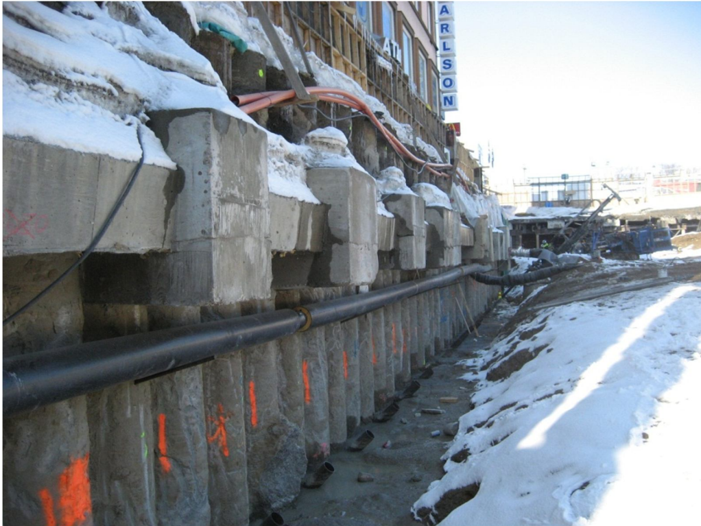
Kuva 22. Toisen ankkurointitason maaputkien porausta. Yläpuolella edellisen kuvan ensimmäinen ankkurointitaso valmiina. Ankkurilinjalle on valettu betonipalkki ja varsinainen ankkurien ympärille on valettu betonikuori. Kuva: Risto Savolainen 2011
