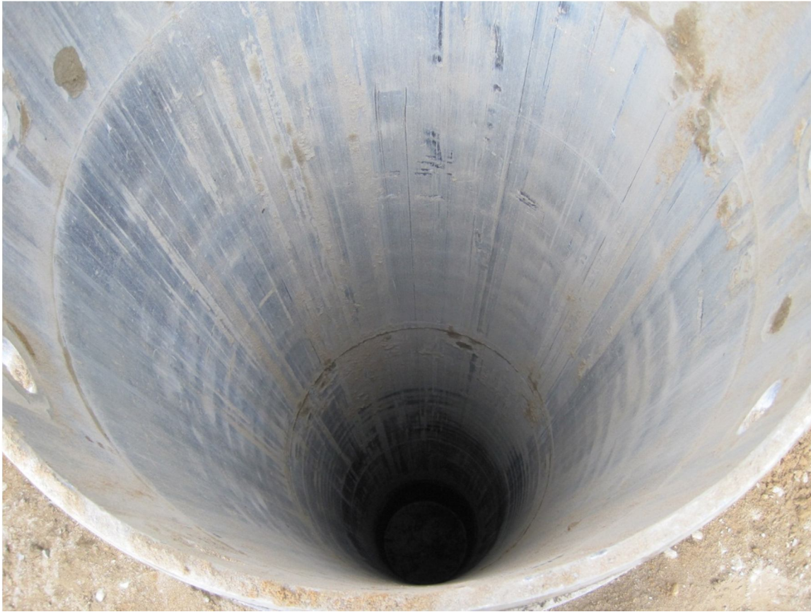
Kuva 11. Keskeneräinen työputkella tuettu paalukaivanto. Kuva: Risto Savolainen 2010
