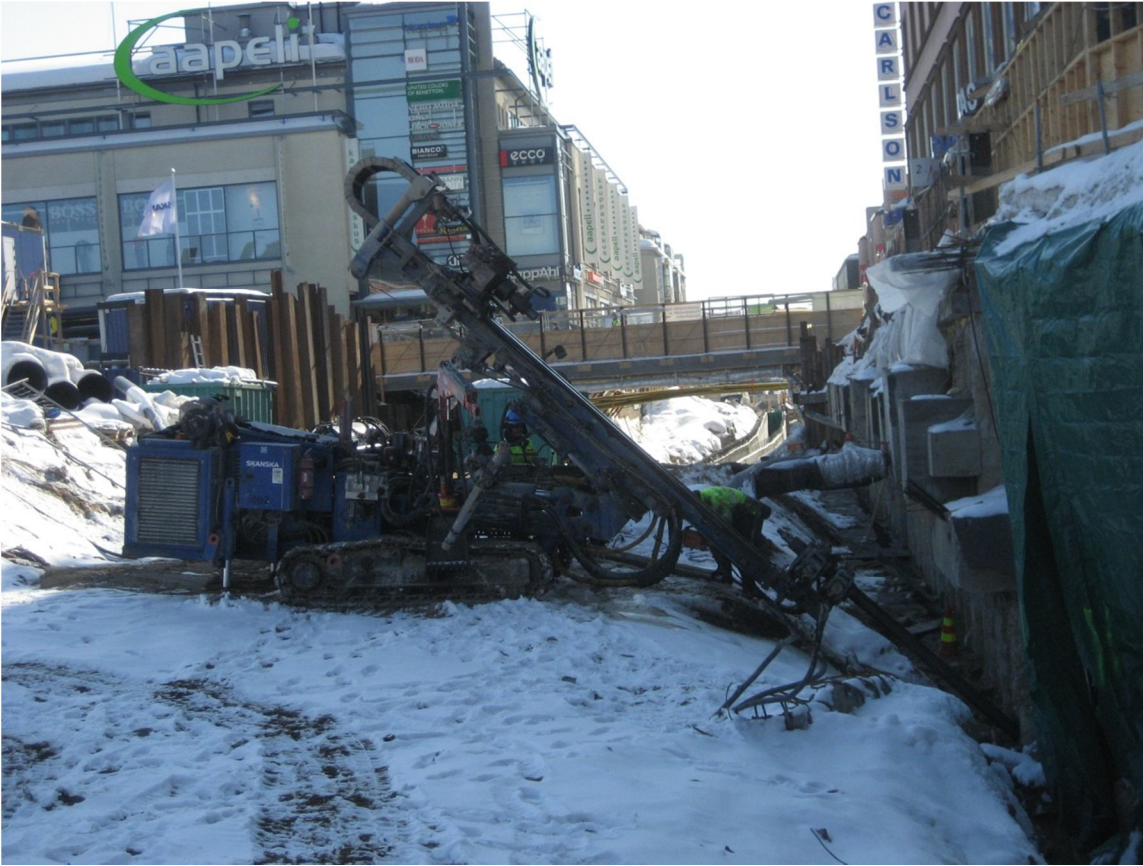
Kuva 19. Ankkurointiin käytettävä poravaunu ankkurointityössä. Kuva: Risto Savolainen 2011
