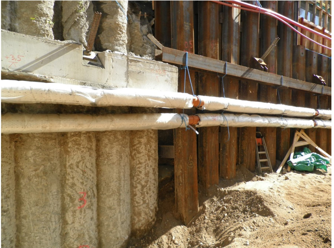
Kuva 32. Kivisestä ja tiukasta maaperästä johtuen teräsponteja ei ole saatu lyötyä määräsyyvyyteen ja osa ponteista on mennyt vinoon. Kuva: Risto Savolainen
