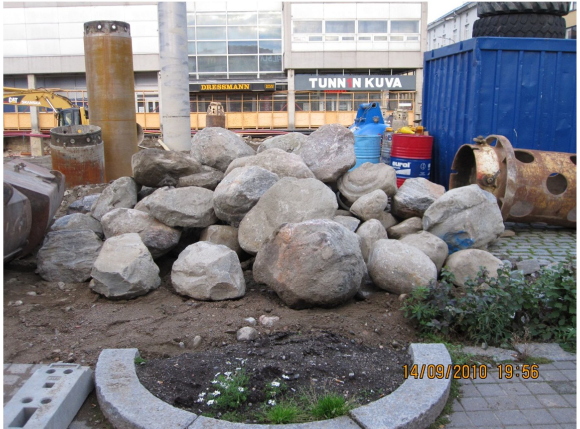
Kuva 30. Paalukaivannosta nostettuja kiviä ja lohkareita. Kuva: Niko Asikainen 2010
