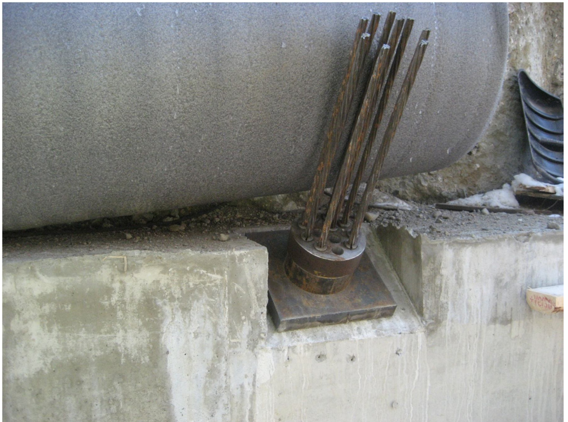
Kuva 20. Ankkuri jossa vastinkappale on paikallaan ankkurointipalkissa ja ankkuri on jännitetty ja jännitys lukittu vastinkappaleeseen. Vaijereiden ylijääviä osia ei ole vielä katkaistu eikä ankkurin yläpäätä ole koteloitu betonivaluun. Kuva: Risto Savolainen 2011
