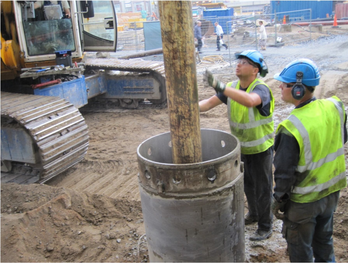
Kuva 15. Valuputken laskeminen paalukaivantoon betonointia varten. Kuva: Risto Savolainen 2010
