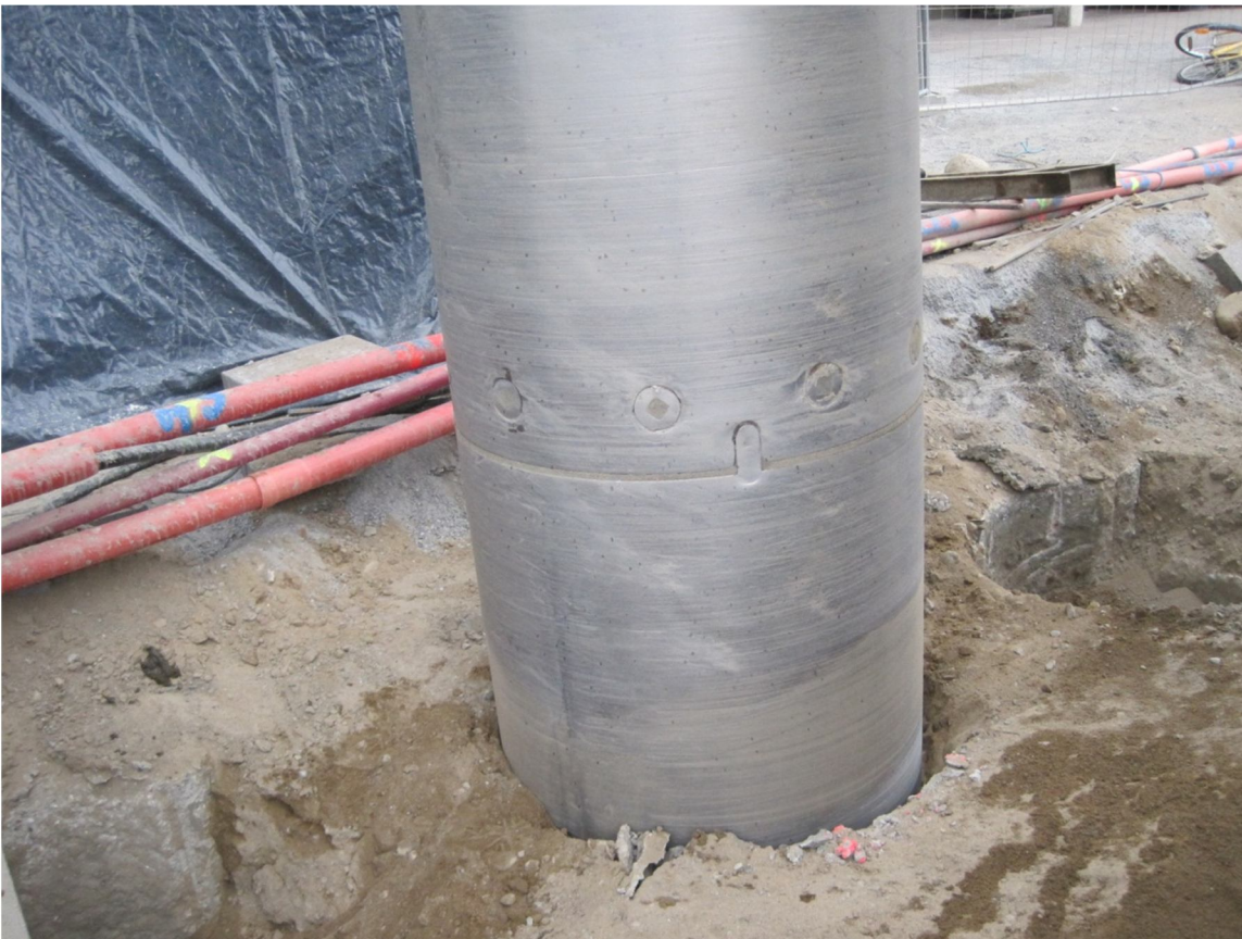
Kuva 8. Työputkien liitos. Kuva: Risto Savolainen 2010
