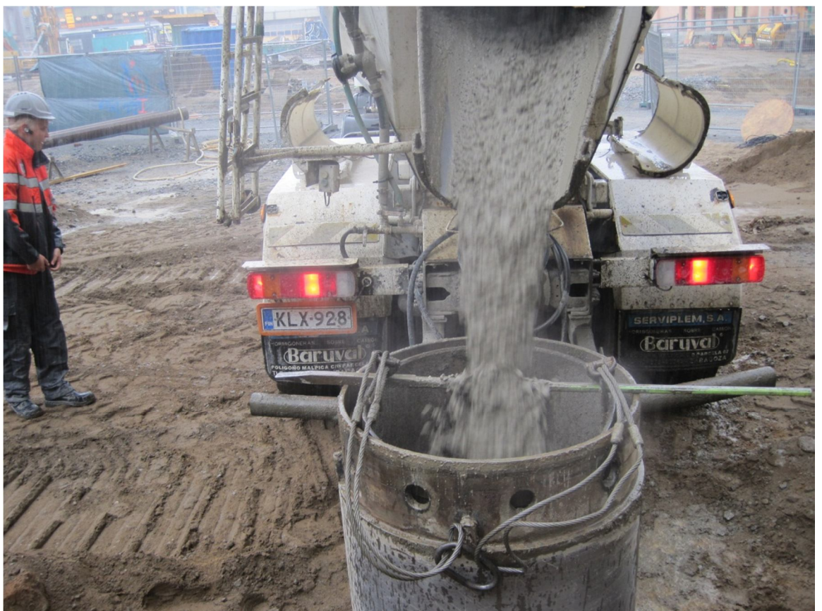
Kuva 17. Betonin laskeminen paalukaivantoon. Kuva: Risto Savolainen 2010
