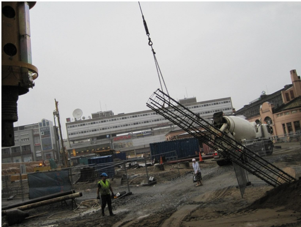
Kuva 12. Raudoitetta ollaan nostamassa paalutuskoneen apuvinssillä.
