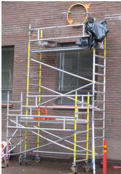
Kuva 56. Työtelineet ja kehysrengas. (Hedengren 2009)
