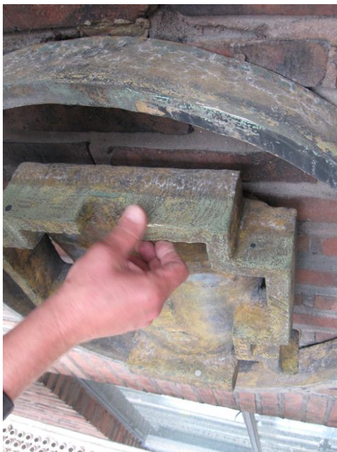
Kuva 39. Seinän ja koristeen välissä näkyy pieni rako. Tyttöreliefi seinällä ennen irrotusta. (Hedengren 2008)
